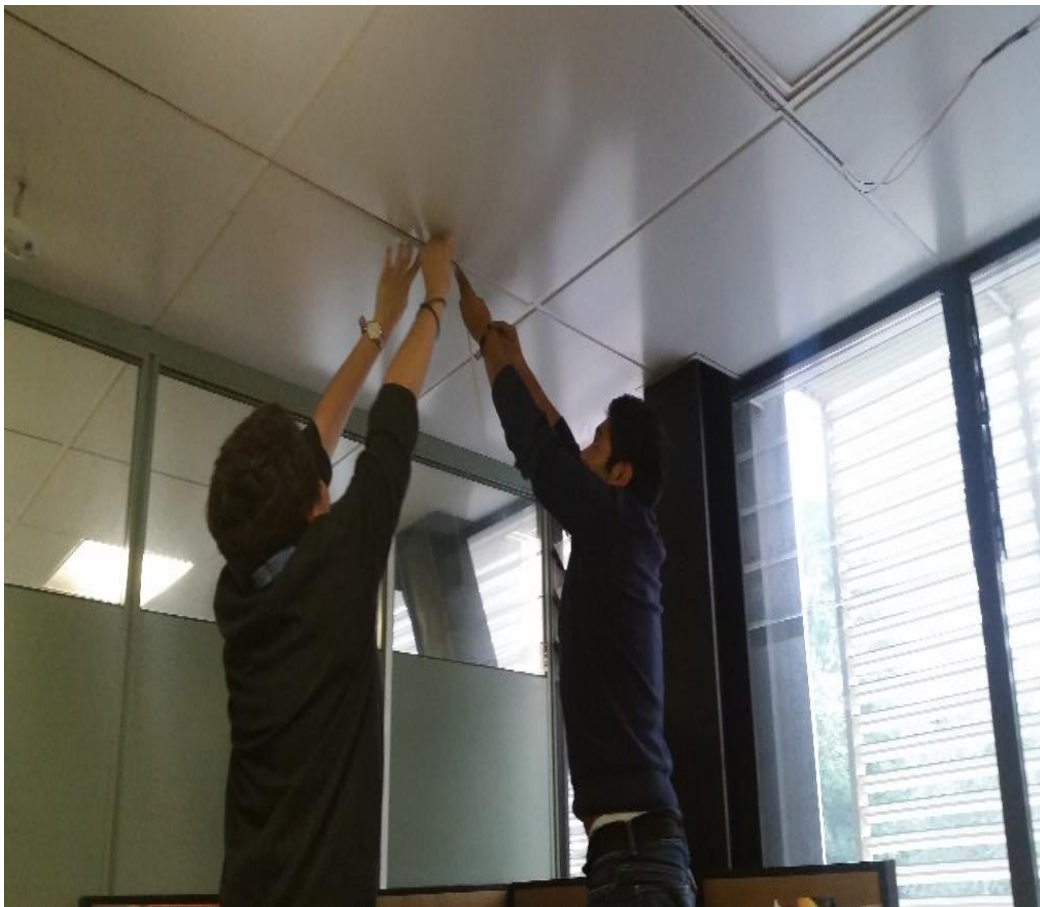
Figura 3.13 Instalación del sistema de iluminación.
