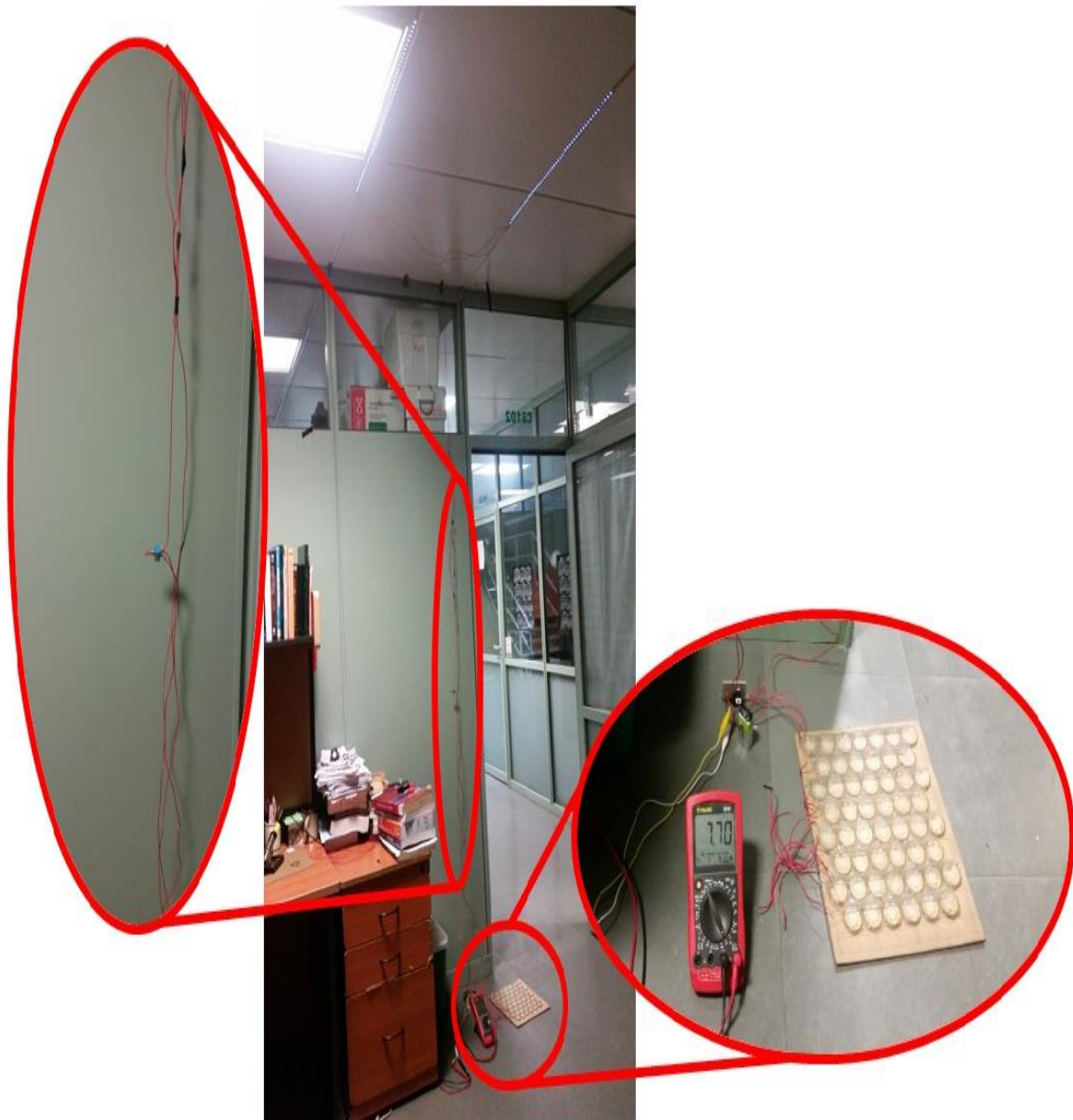
Figura 3.14 Instalación de la baldosa piezoeléctrica.
