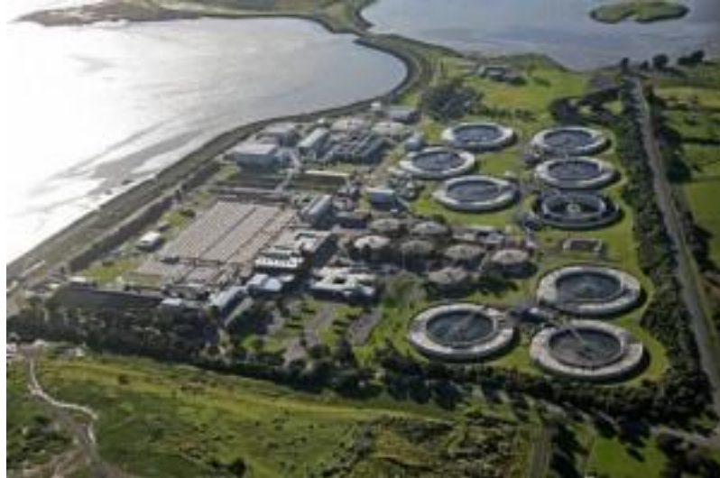
Figura V.5 Planta de Tratamiento de Aguas Residuales de Atotonilco en Hidalgo.
