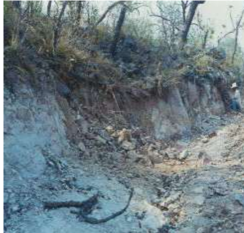
Figura 40. Corte en balcón CB-9, donde se observa material arcilloso. (CFE, 2013).
