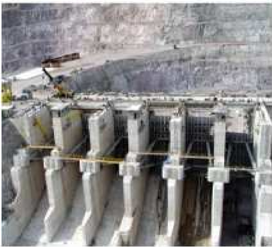
Figura 4: (Fuente, GEIC, Pagina Acerca de Nosotros) (Representa a las disciplinas) Construcción de compuertas de una presa.
