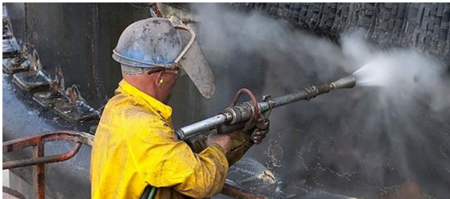
Figura 2.5. Limpieza a alta presión [13].
