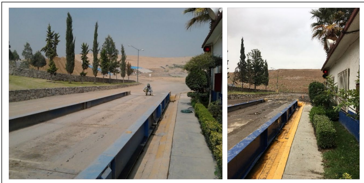
Figura 19. Báscula de camiones y oficinas del Relleno Sanitario. Años: 2012 (izquierda), 2018 (derecha)
