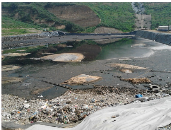
Figura 23. Celda acondicionada para reposición de residuos. En época de lluvia se genera 1.4 \text{ l s}^{-1} . Año: 2012
