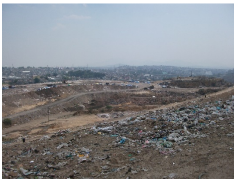
Figura 32. Celdas activas 4 y 6 consideradas de emergencia. Año: 2018
