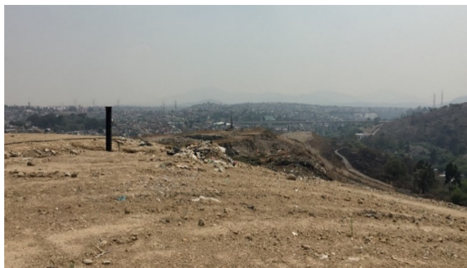
Figura 15. Pozo de extracción en la cima del Relleno Sanitario. Año: 2018
