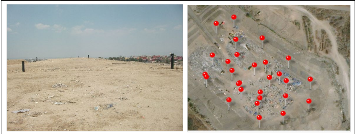
Figura 35. Izquierda: Pozos de extracción de Biogás. Derecha: Pozos geo referenciados de Celda 7. Año: 2018
