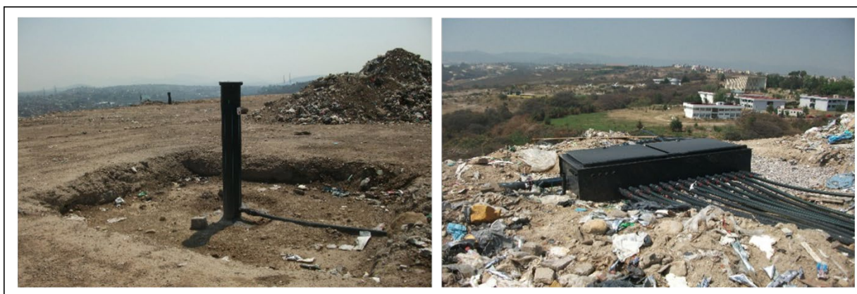
Figura 34. Izquierda: Pozo de extracción de Biogás. Derecha: Colector de Biogás tipo ERM. Año: 2018
