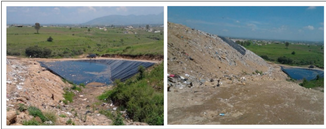
Figura 12. Laguna de lixiviados sin malla perimetral. Año: 2012
