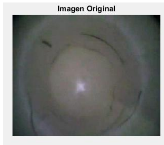
Figura 85. Fotograma extraído del video del interior de la tubería.
