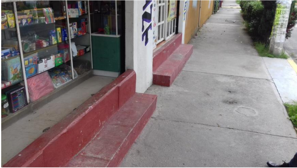
Imagen 14 Vista de una medida preventiva para evitar afectaciones por las inundaciones
