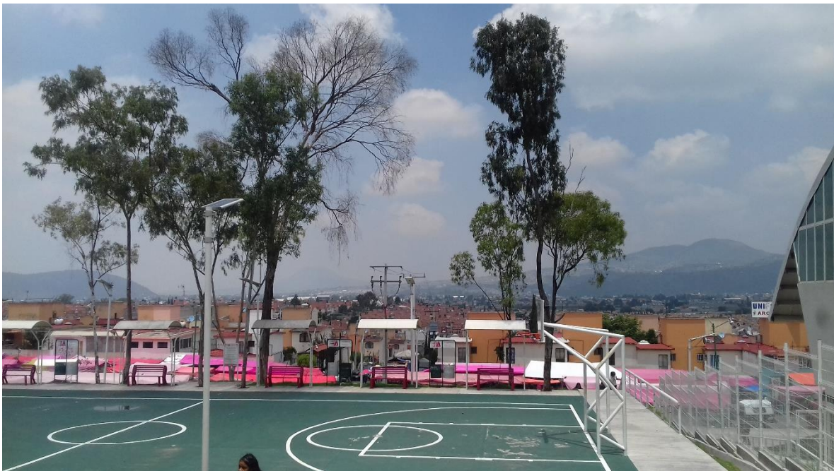
Imagen 6 Vista de la zona intermedia del Conjunto San Buenaventura
