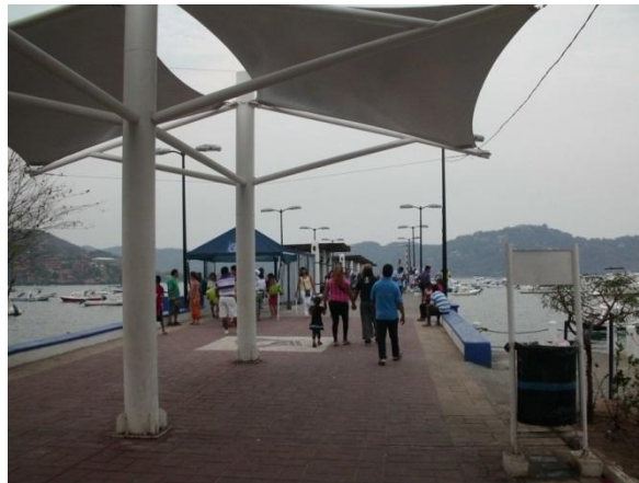
Imagen 32. Remodelaciones en el muelle con pavimentos nuevos color rojo, techos modernos (velarias) iluminación, bancas, un espacio accesible. Autor: LEGC, fecha: 03/2013
