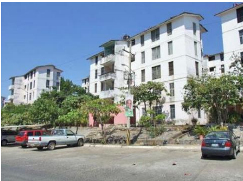
Imagen 8. Complejo habitacional el INFONAVIT el Hujal ubicado sobre el boulevard Aeropuerto-Ixtapa.
