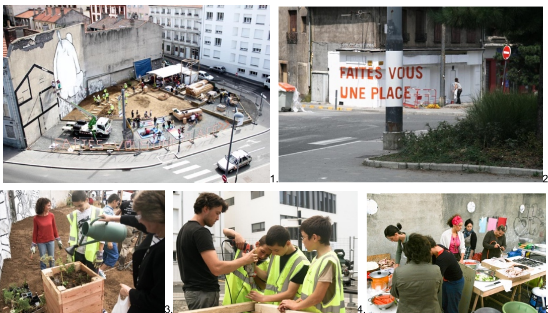
Foto 1; 2; 3; 4; 5. Collectif Etc. (2011). Place au change [Fotografía]. Collectif Etc.5. http://www.collectifetc.com/realisation/place-au-changement-chantier-ouvert/
