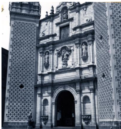
FOTO No. 10 ATRIO SIN DESNIVEL
