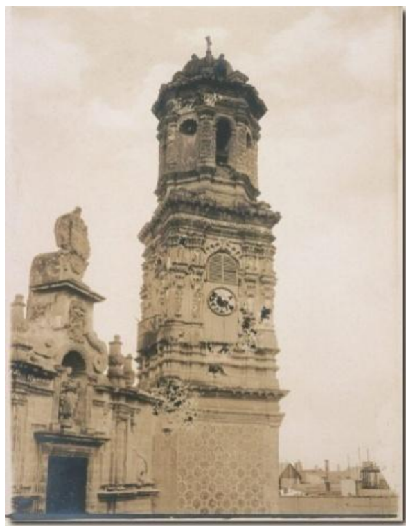
FOTO No. 1 TORRE CAMPANARIO ORIENTE
