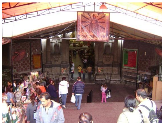
FOTO No. 11 ATRIO CON HUNDIMIENTO Y ESCALINATAS
