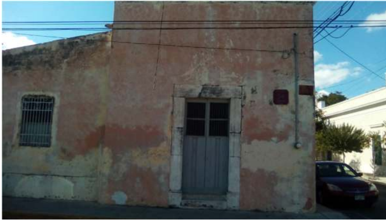
Ilustración 24 Detalle de jambas y dintel a base de sillería de la región, usado en el virreinato. Foto: H.N.M. (2018)
