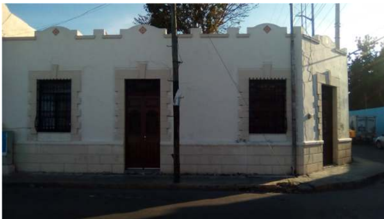
Ilustración 30 Detalle de escalonamiento en caballetes y pretilos, enmarcamiento de acceso. Foto: H.N.M. (2018)
