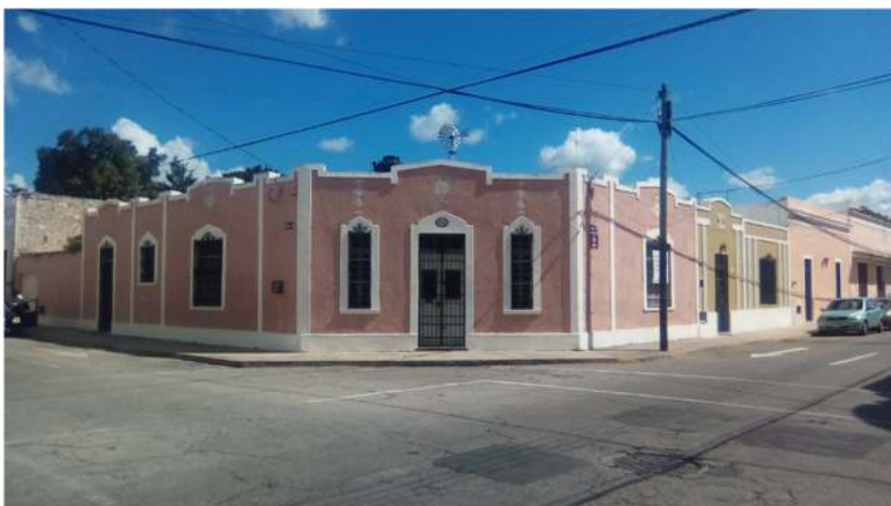
Ilustración 50 Fachada Art Decó en el Barrio de Santiago. Foto: H.N.M. (2018)
