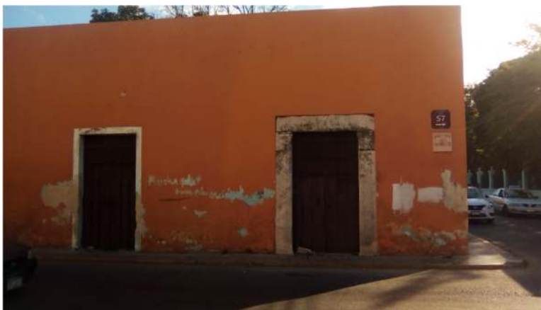
Ilustración 23 Detalle de jambas y dintel a base de sillería de la región, usado en el virreinato. Foto: H.N.M. (2018)
