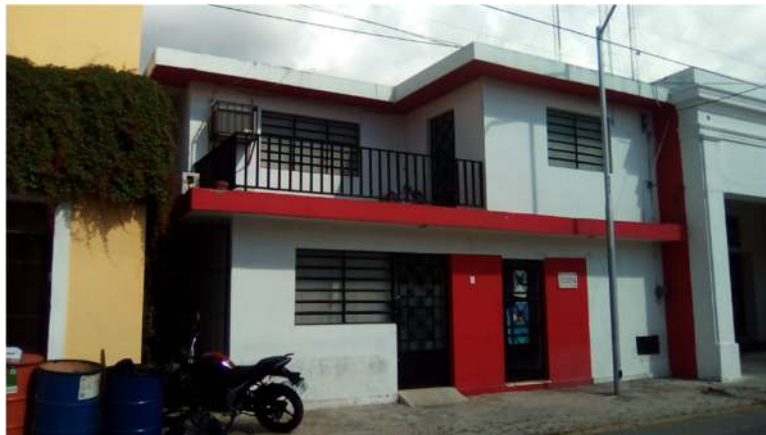
Ilustración 21 Fachada Moderna. Foto: H.N.M. (2018)
