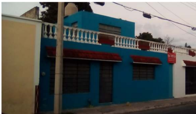
Ilustración 20 Fachada Moderna. Foto: H.N.M. (2018)
