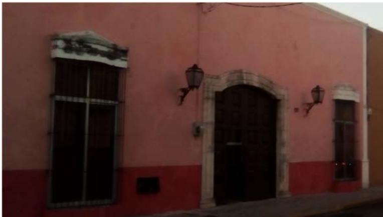
Ilustración 25 Detalle de ventanas y acceso con dintel de arco escarzano característico de la arquitectura virreinal en Yucatán. Foto: H.N.M. (2018)
