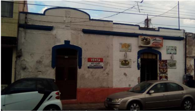
Ilustración 45 Fachada Neomaya en el Barrio de San Sebastián. Foto: H.N.M. (2018)
