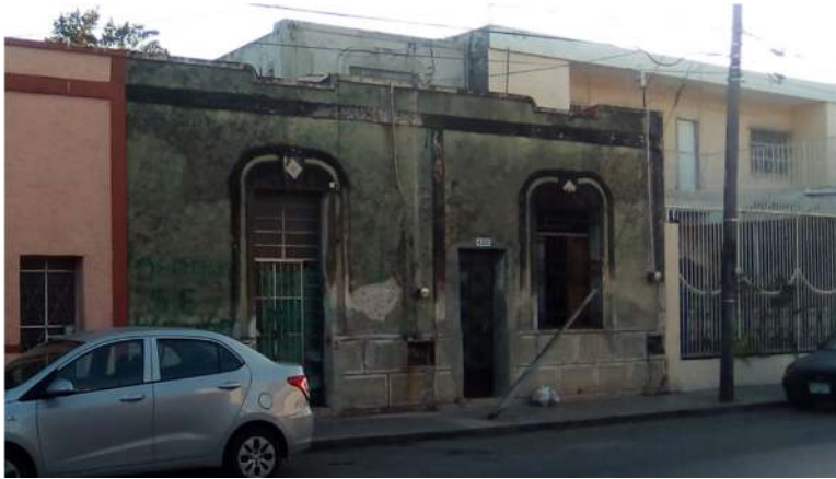
Ilustración 31 Detalle de elementos decorativos sobre acceso y platabandas en relieve. Foto: H.N.M. (2018)
