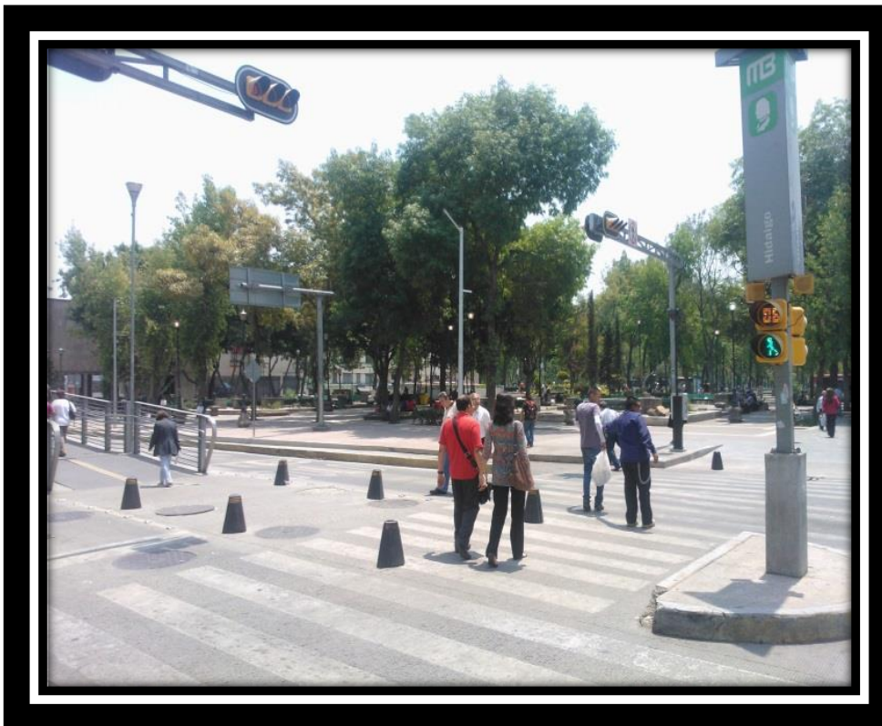
Figura 16. Cruce con diseño universal, se observan los bolardos, cruce a nivel de piso y bahía de protección. Av. Juárez Fuente: Elaboración Propia
