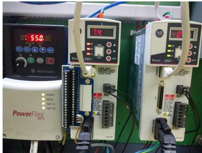
Figura 5.31: Dispositivos en falla cuando se pierde la comunicación con el puerto 3.
