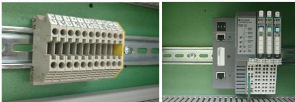
Figura 3.33: dispositivos montados sobre rieles din.
