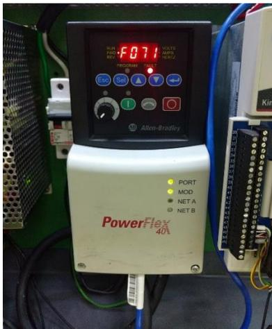
Figura 5.37: Dispositivos en falla cuando se pierde la comunicación con el puerto 4.
