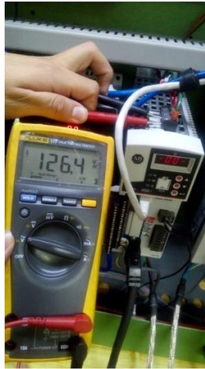
Figura 5.4: Medición de tensión del Kinetix 350.
