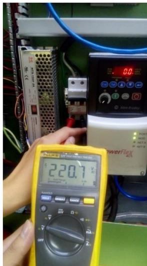
Figura 5.3: Medición de la tensión de entrada del PowerFlex.
