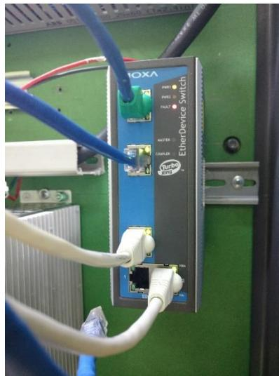
Figura 5.14: Desconexión del cable (puerto 1).
