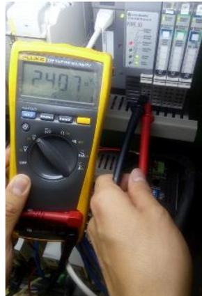
Figura 5.6: Alimentación del Point I/O.
