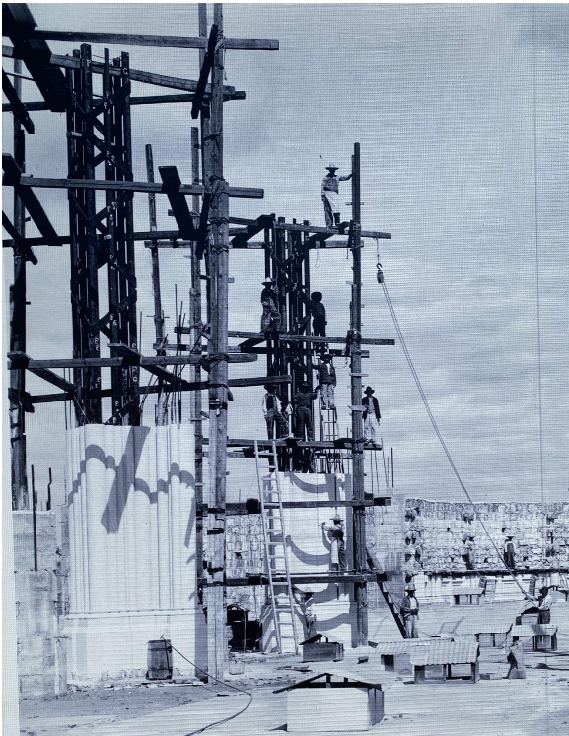
Figura79. Construcción de Columnas S. XX _ Proceso Constructivo del T.E.D.S.C.J. (Crónica Fotográfica del Centenario, 2022)
