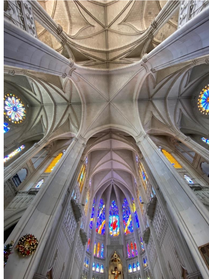
Figura55. Sistema de bóvedas de cruceira. (Martínez, 2022)
