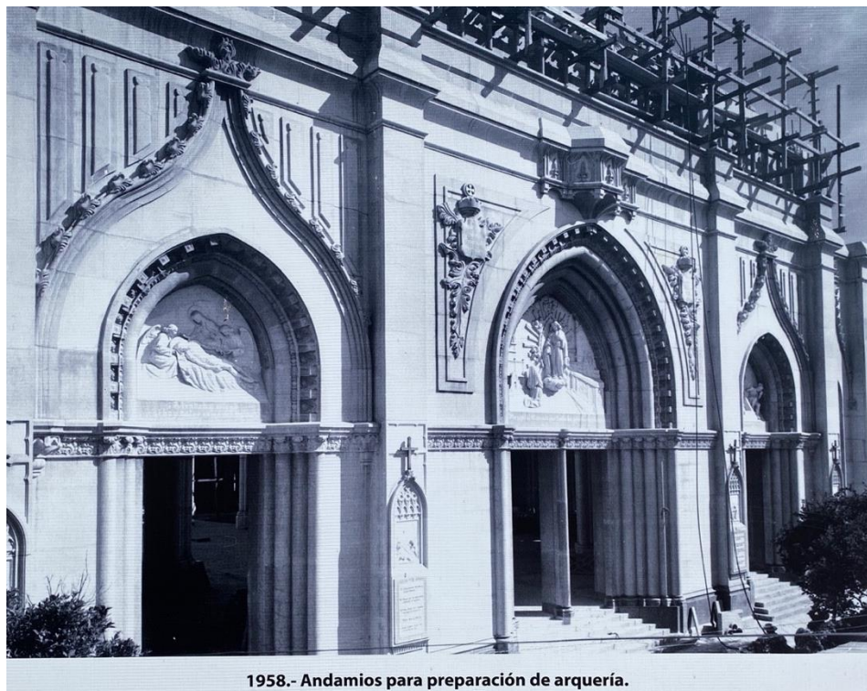
Figura89. Andamios para preparación de arquería _ Proceso Constructivo del T.E.D.S.C.J. (Crónica Fotográfica del Centenario, 2022)
