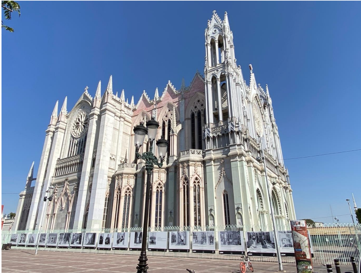
Figura61. Costado poniente, con sistema de arbotantes de carácter decorativo. (Martínez, 2022)
