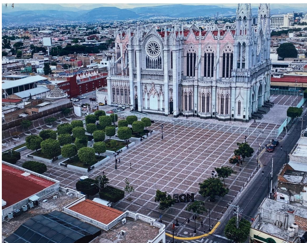
Figura93. Vista Aérea en Proceso Constructivo del T.E.D.S.C.J. (Crónica Fotográfica del Centenario, 2022)
