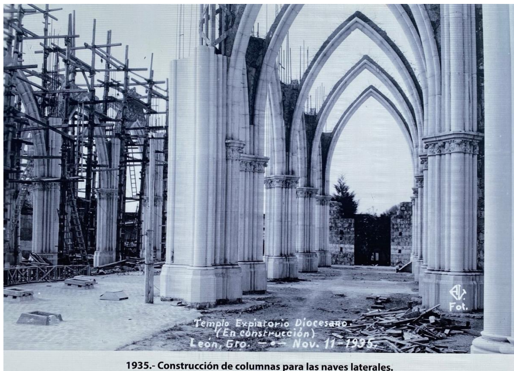
Figura80. Naves Laterales _ Proceso Constructivo del T.E.D.S.C.J. (Crónica Fotográfica del Centenario, 2022)
