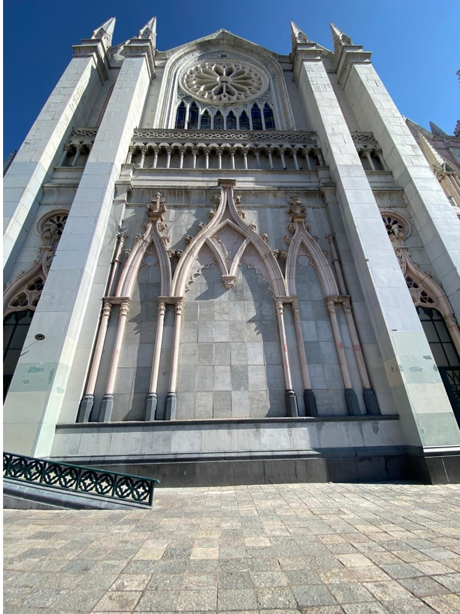
Figura58. Contrafuertes lado Oriente del Templo. (Martínez, 2022)
