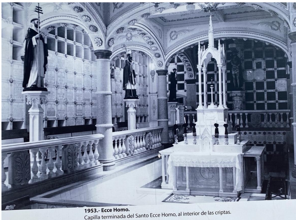
Figura84. Capilla terminada _ Proceso Constructivo del T.E.D.S.C.J. (Crónica Fotográfica del Centenario, 2022)
