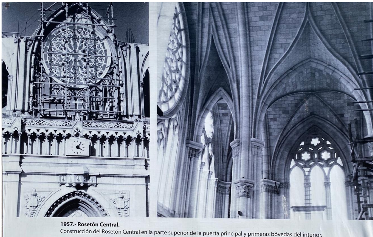
Figura85. Rosetón central _Proceso Constructivo del T.E.D.S.C.J. (Crónica Fotográfica del Centenario, 2022)
