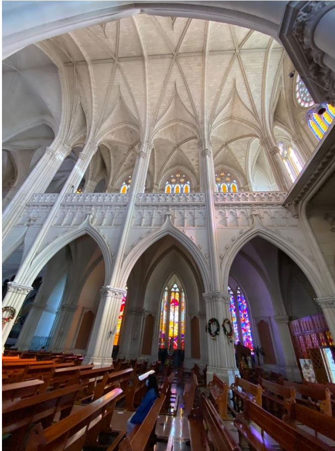
Figura54. Abovedamiento de la nave central y triforio. (Martínez, 2022)
