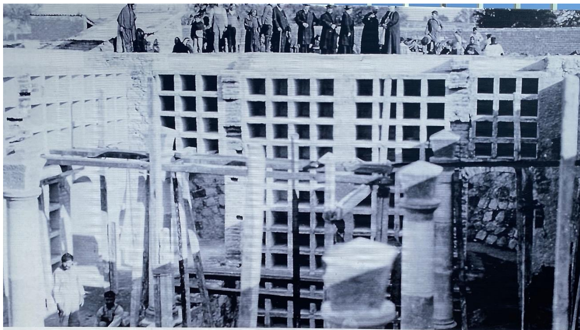
1929.- Avance criptas y columnas.
