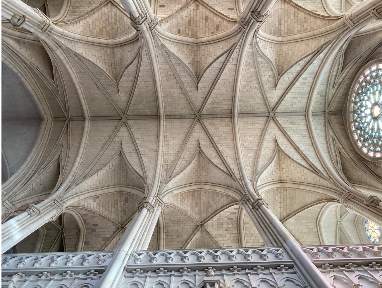
Figura56. Sistema de abovedamiento de nave central y laterales Templo Expiatorio, León Guanajuato. (Martínez, 2022)
