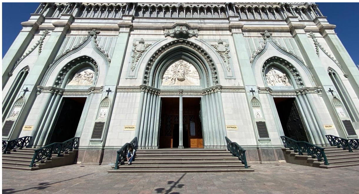
Figura62. Presencia de los arcos de ojiva, en portada principal. (Martínez, 2022)
