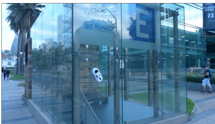
Fig. 14. Limpieza en fachada de vidrio por un Skycleaner. [26]
