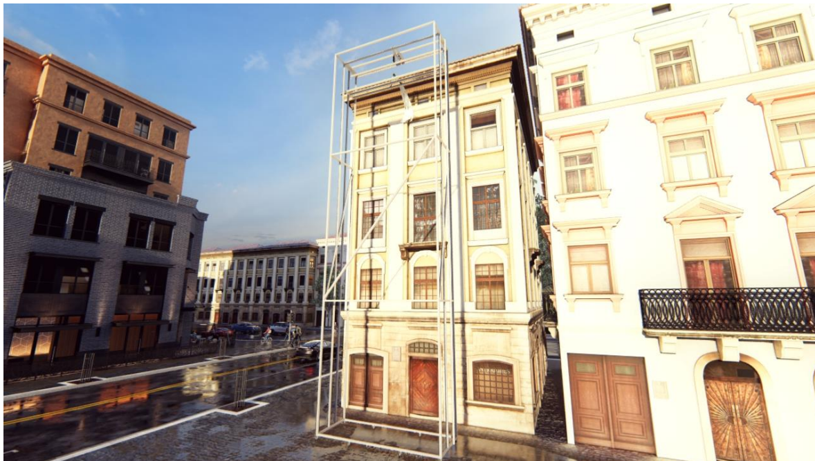
Fig. 54. Animación del dispositivo de asistencia, desarrollando tarea de limpieza en fachada de edificio.
