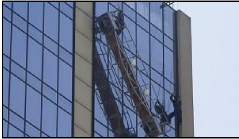
Fig. 6. Accidente ocurrido durante limpieza de fachada. [14]
