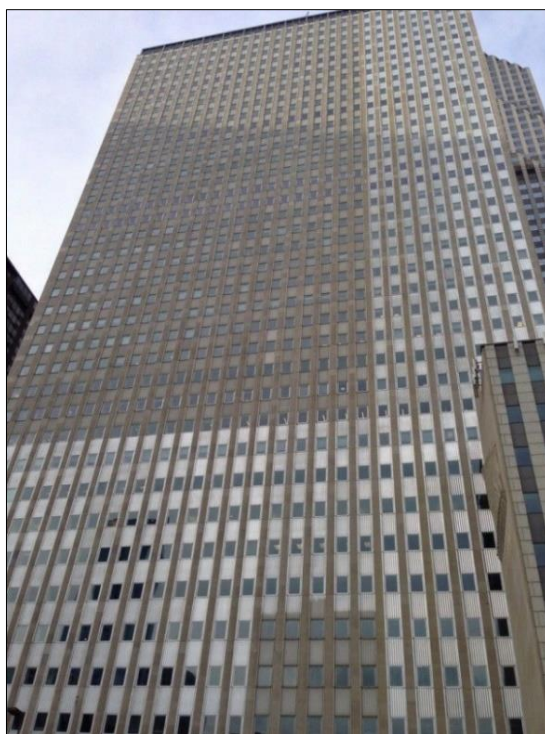
Fig. 3. Limpieza de fachada. [8]
