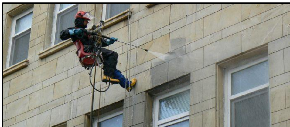
Fig. 5. Operador realizando tareas de limpieza en una fachada. [13]
