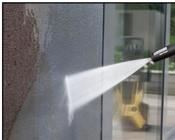
Fig. 4. Fachada sometida a limpieza con chorro de agua a alta presión. [11]
