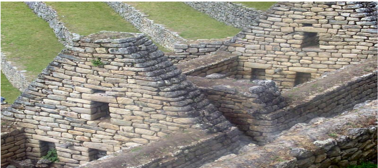
Muros de piedra, Machupicchu, Cusco, Perú.
