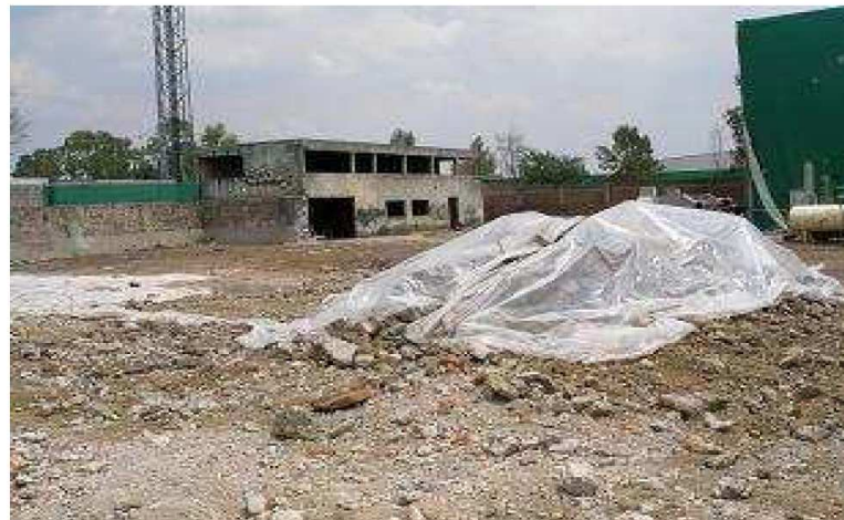
BANCO DE TIERRA Y MATERIAL CONTAMINADO
