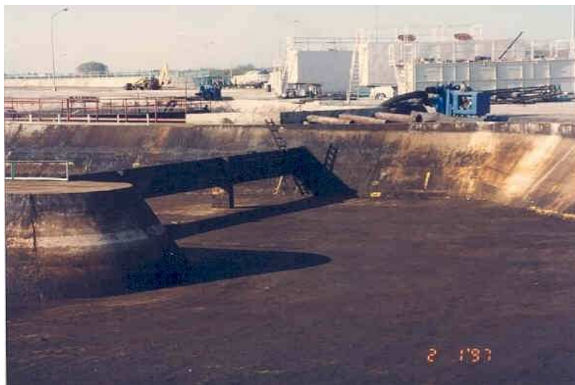
LIMPIEZA DE LAGUNAS DE OXIDACIÓN
