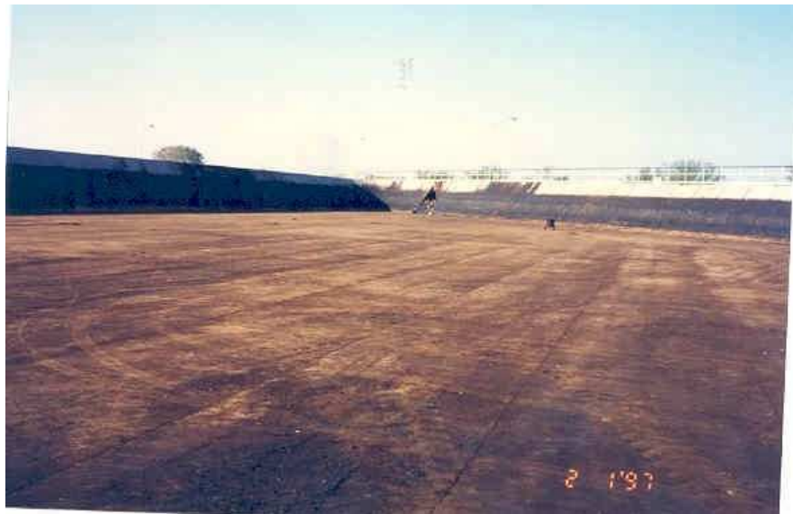
LIMPIEZA DE LAGUNAS DE OXIDACIÓN
