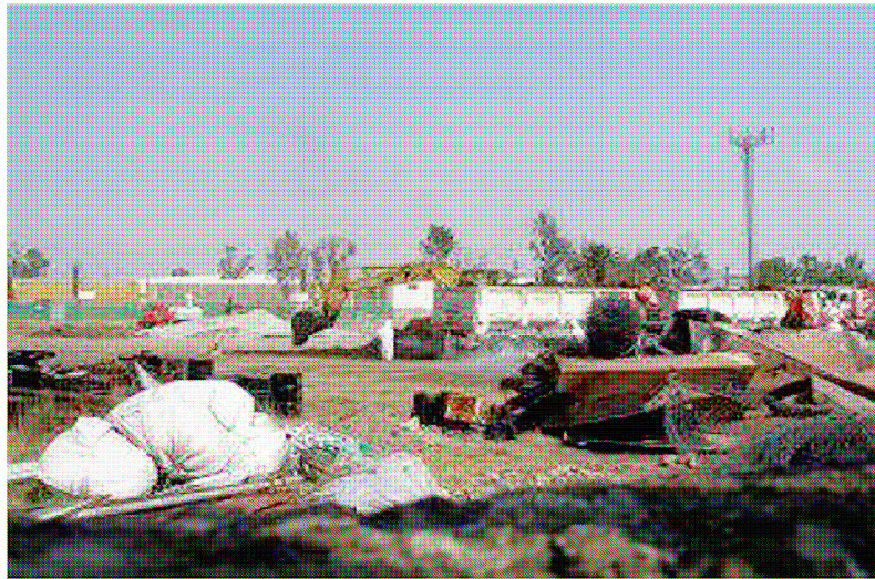
VISTA GENERAL DEL AREA DE TRABAJO
