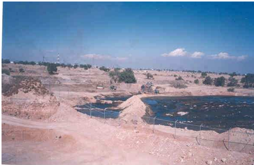
LIMPIEZA DE LAGUNAS DE OXIDACIÓN
