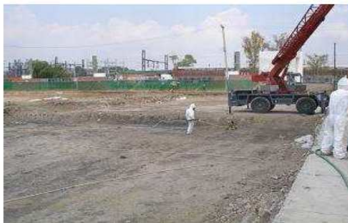
PERSONAL ESPECIALIZADO EN LAS LABORES DE REMEDIACION
