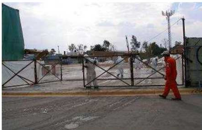
PERSONAL ESPECIALIZADO EN LAS LABORES DE REMEDIACION
