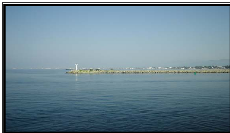
Fig. 1.3.2.2 Escollera del puerto de Manzanillo.
