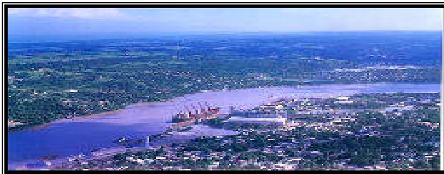
Fig. 1.3.2.5 Vista del canal de navegación del puerto Tampico.
