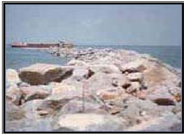
Fig. 1.3.1 Rompeolas a talud de enrocamiento.
