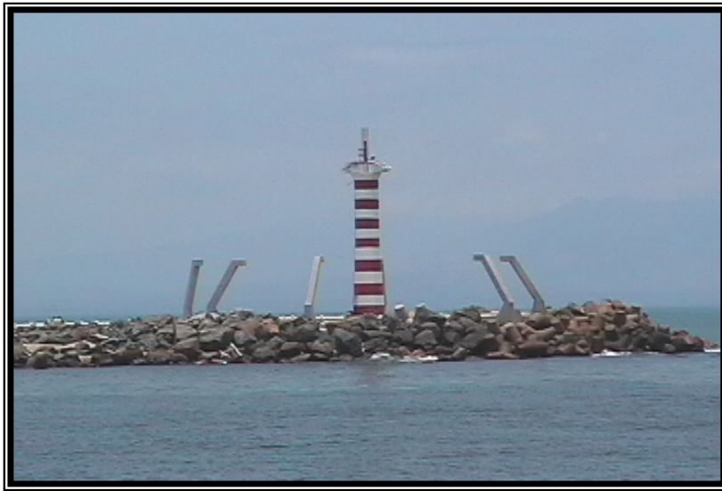
Fig.1.3.2.7 Escollera del puerto de Coatzacoalcos.
