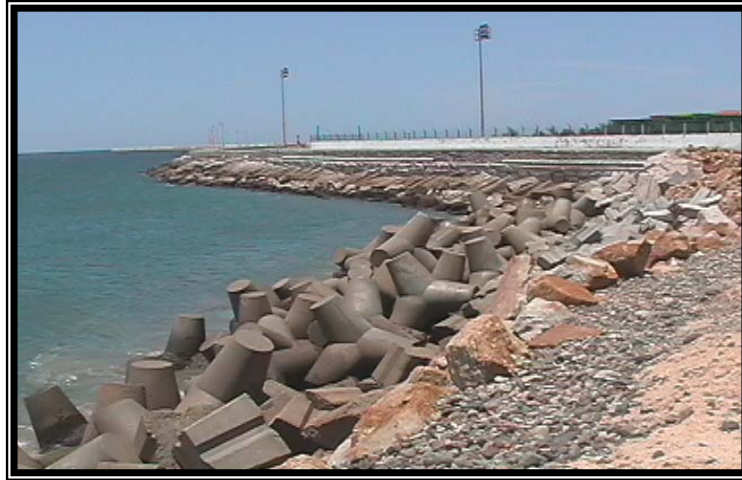
Fig. 1.3.2.4 Rompeolas del puerto de Salina Cruz.
