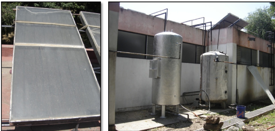
FIGURA 3-9 Colectores solares para regaderas, Cortesía de la UDLA Puebla
