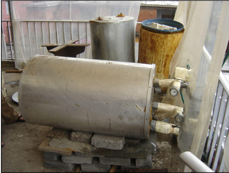
FIGURA 7-1 Tanque aislado de almacenamiento. Volumen igual a 300 Litros. Cortesía de la familia Aceves Bernal
