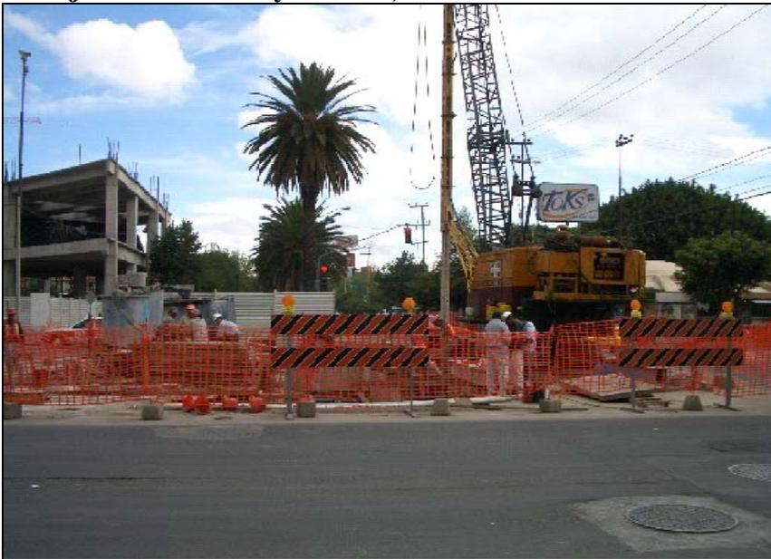
Modificación de la infraestructura vial y los servicios, alteración de colector de 1.80 metros de diámetro, drenaje, agua potable y electrificación, por la construcción del megaproyecto de usos mixtos *Antara Polanco*.
