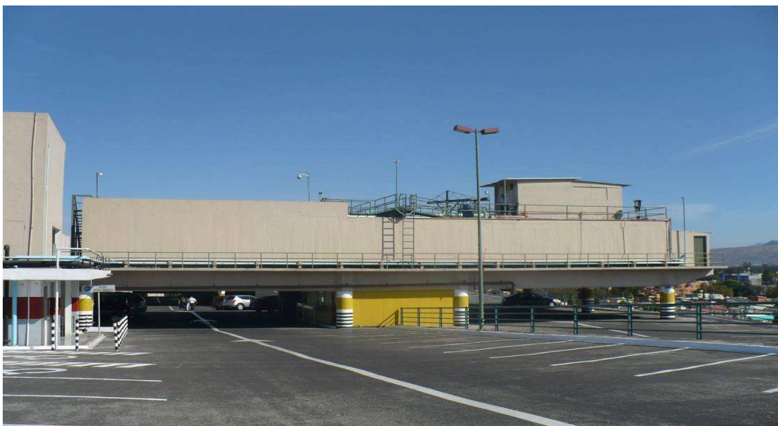
Fotografía general de la Planta de tratamiento de aguas residuales de Galerías Coapa.
