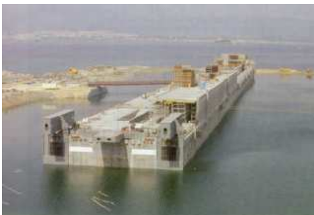
FIG. 8 Flotación del dique rompeolas. Bahía de Argel 19 de Junio de 2002.
