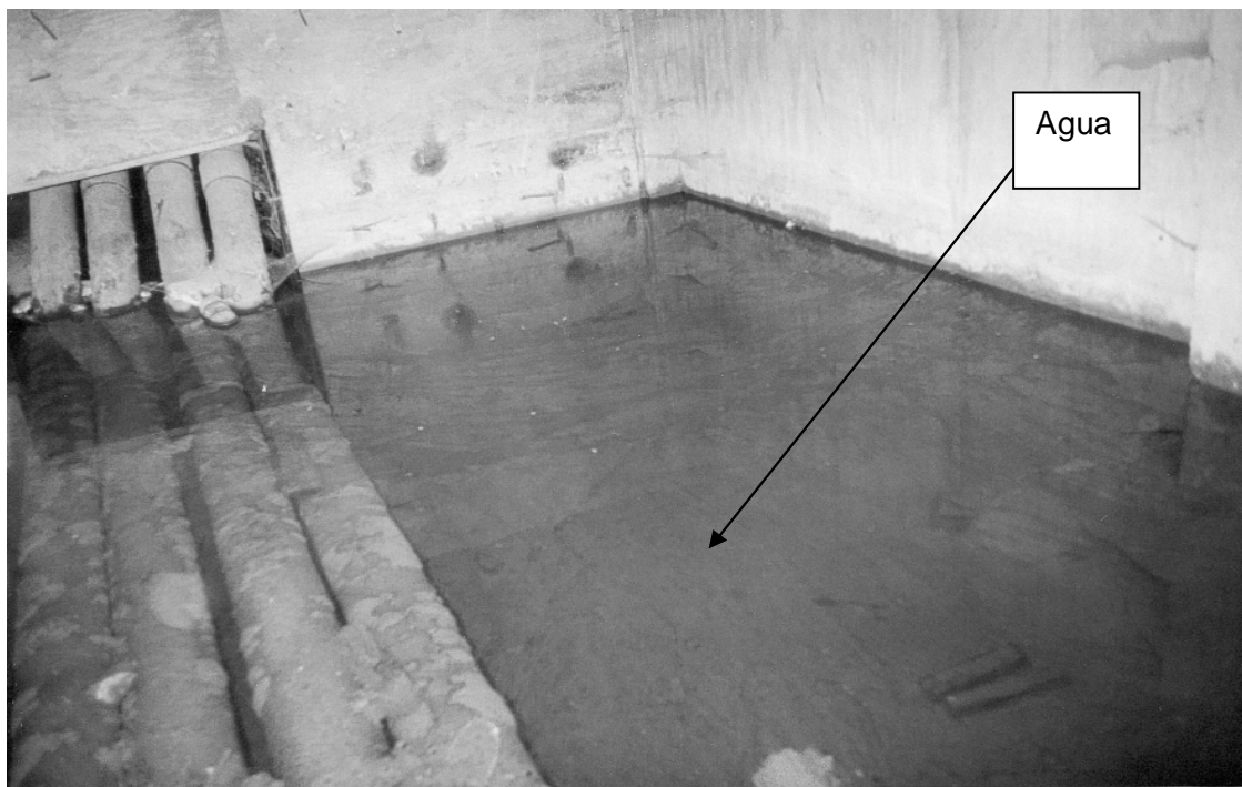
Figura 1. Área del sótano
