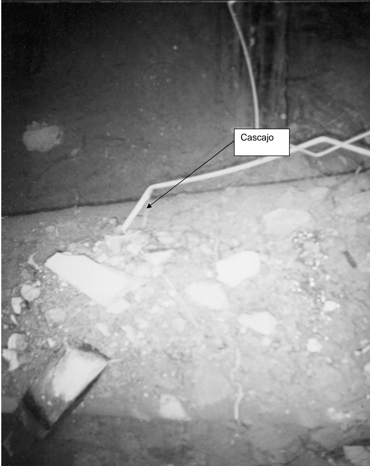
Figura 1. Área del sótano
