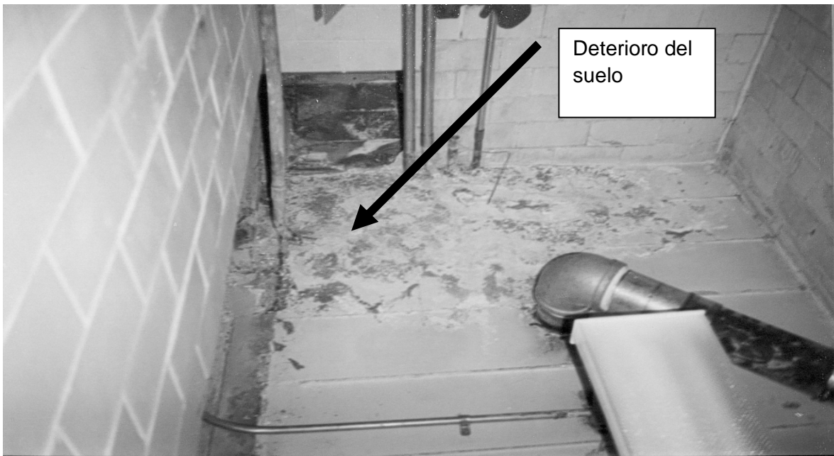
Figura 1. Área del sótano
