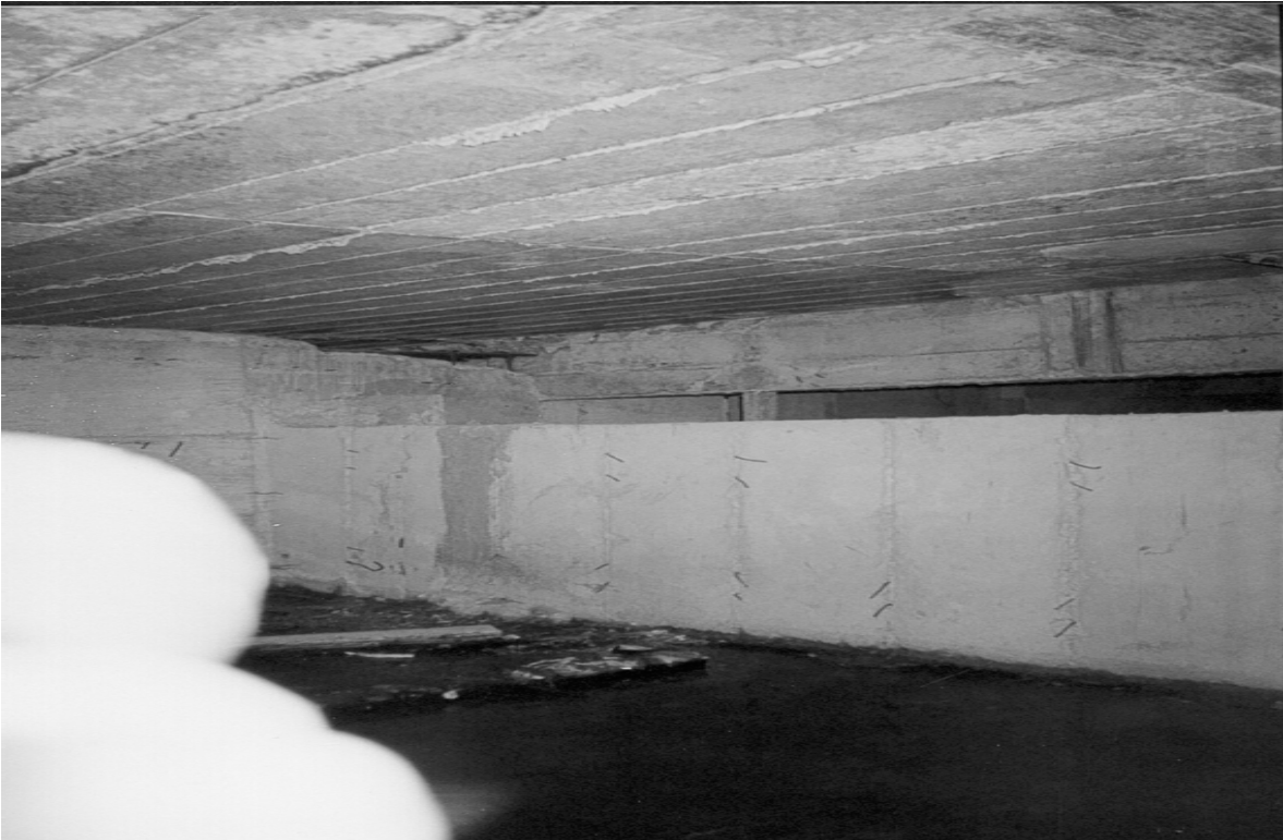
Figura 1. Área del sótano
