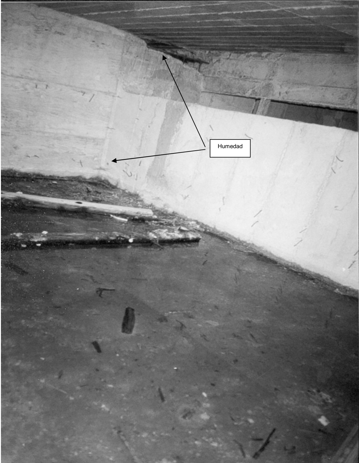
Figura 1. Área del sótano
