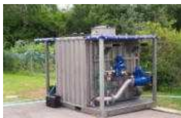
Fig. 2 Sistema de ultra filtración Huber VRM
