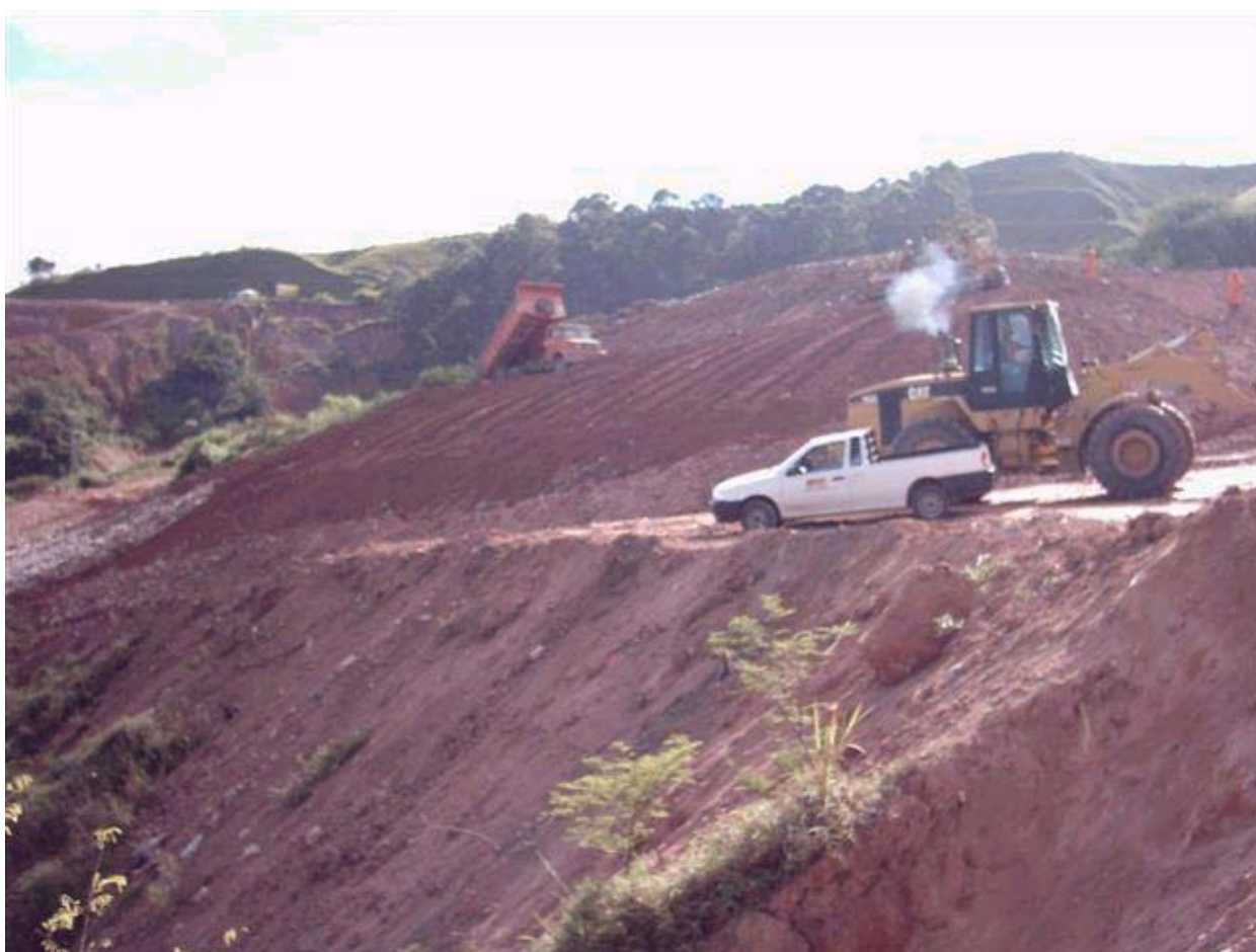
Fig. 11a: Construcción de taludes
