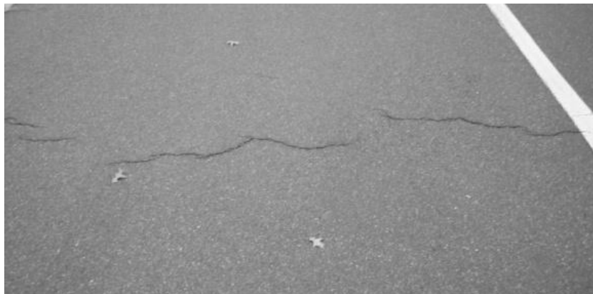
Figura 3. 9 Agrietamiento transversal.
