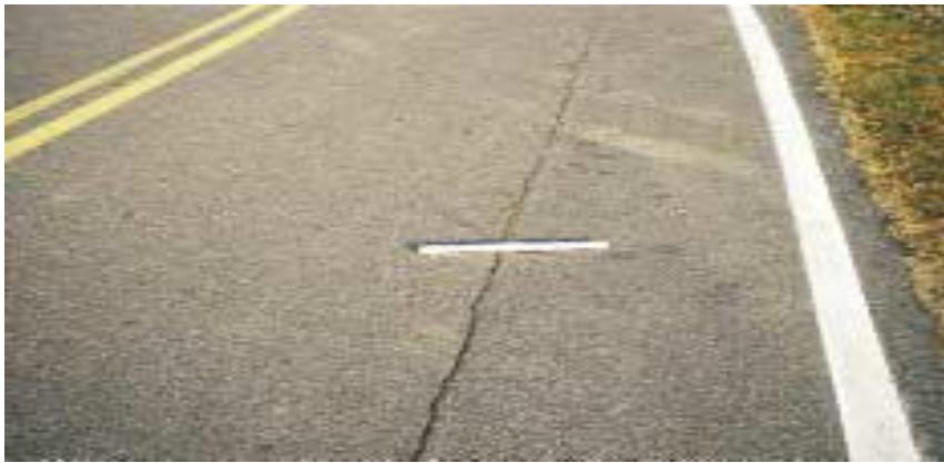
Figura 3. 8 Agrietamiento longitudinal.
