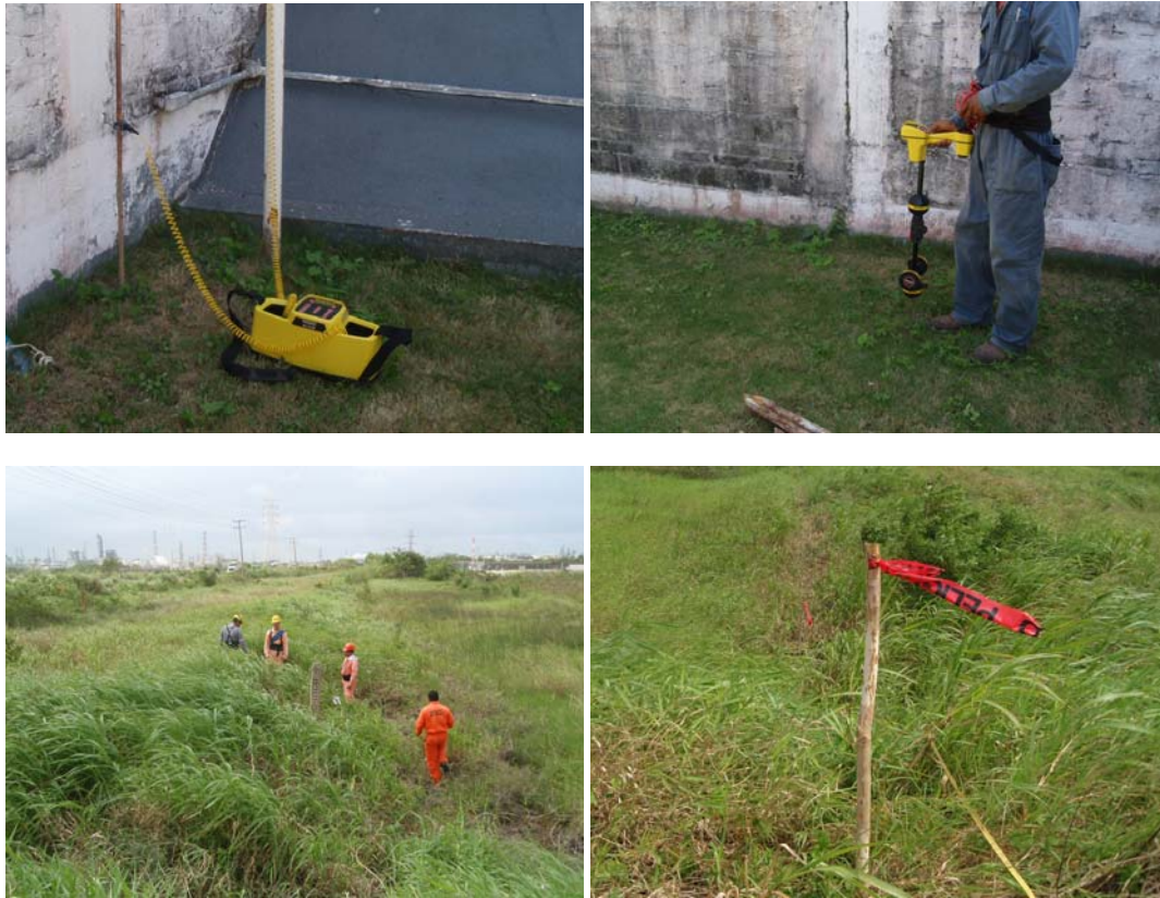
Fig. 117.- Localización de ducto con equipo electrónico (De izquierda a derecha de arriba para abajo, Foto1: Conexión de inductor de señal; Foto 2: Equipo para rastrear tubería, entregando ubicación y profundidad; Foto3 y 4: Recorrido del ducto y colocación de estacas)
