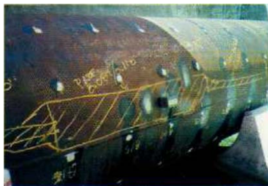
Figura 65.- Tubería con laminación
