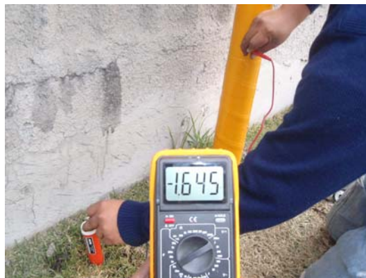
Fig. 113.- Levantamiento del perfil de potenciales Tubo-suelo referidos a una celda de referencia de Cobre Sulfato de Cobre (Cu/CuSO 4 ).
