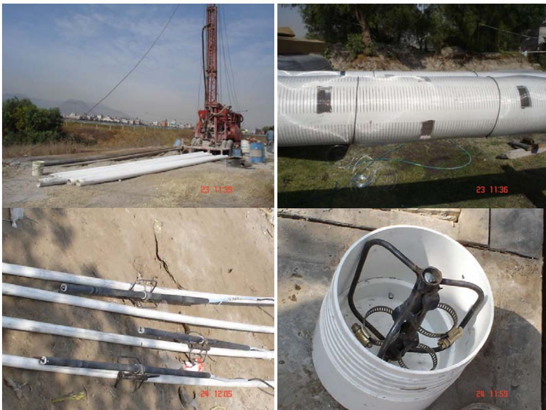
Fig. 111.- Instalación de cama anódica de pozo profundo, ánodos inertes a base de óxidos metálicos (De izquierda a derecha de arriba para abajo, Foto1: Taladro para 100m; Foto 2: Camisa de PVC para rellenar con Backfill; Foto 3: conexión de ánodos al centrador; Foto 4: Vista final de cama anódica para conexión a rectificador)
