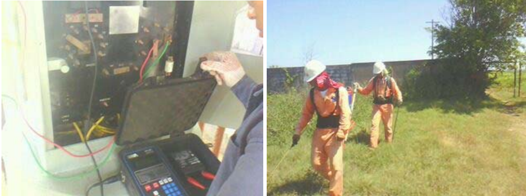
Fig. 112.- Levantamiento de potenciales a intervalos cercanos (CIS) (De izquierda a derecha, Foto1: Conexión de interruptor de corriente, equipo On/Off; Foto 2: Medición de potenciales)
