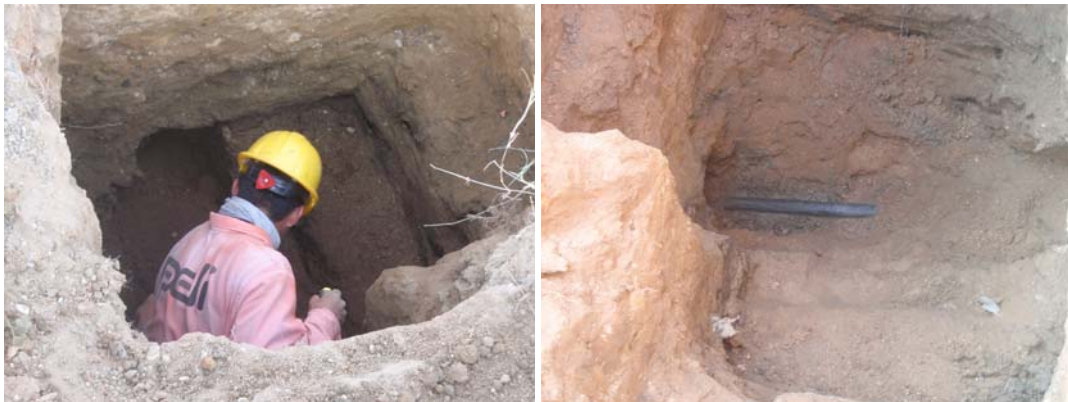
Fig. 121.- Excavación para retirar puenteo eléctrico (De izquierda a derecha, Foto1: excavación en punto localizado mediante equipo electrónico; Foto 2: Eliminación de puenteo eléctrico)
