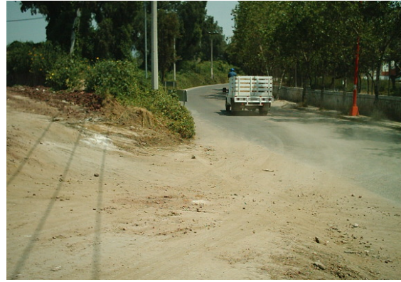
Caminos pavimentados y no pavimentados
