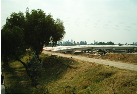
Caminos no pavimentados
