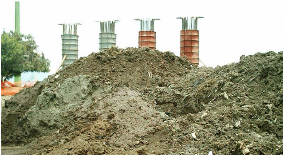
Figura 7.4 Imágenes de la construcción de la vialidad los Remedios-Ecatepec
