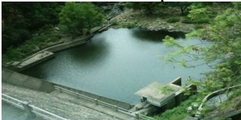
Foto 2.1 Vista de Compuerta
