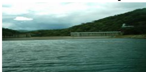
Foto 2.5 Vista de Compuerta
