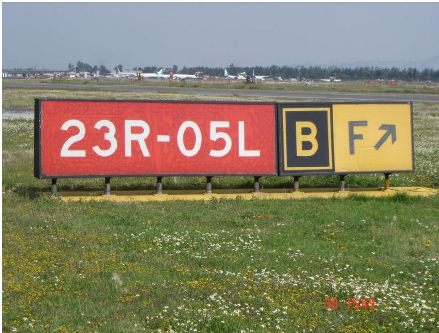
FIG.1.2. Letrero vertical, léase: Pista 23R-05L, continúa carreteo sobre rodaje Bravo, diagonal a la derecha por rodaje Foxtrot.
