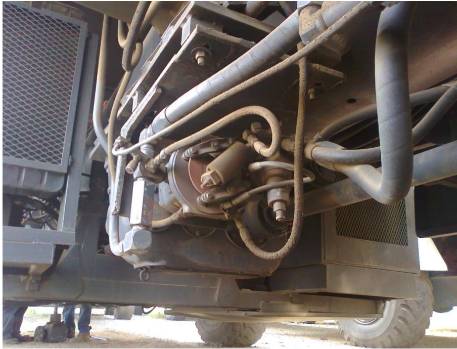
FIG.2.25. Mangueras deterioradas por envejecimiento en la entrada, salida de la toma de fuerza y alimentación del freno hidráulico.
