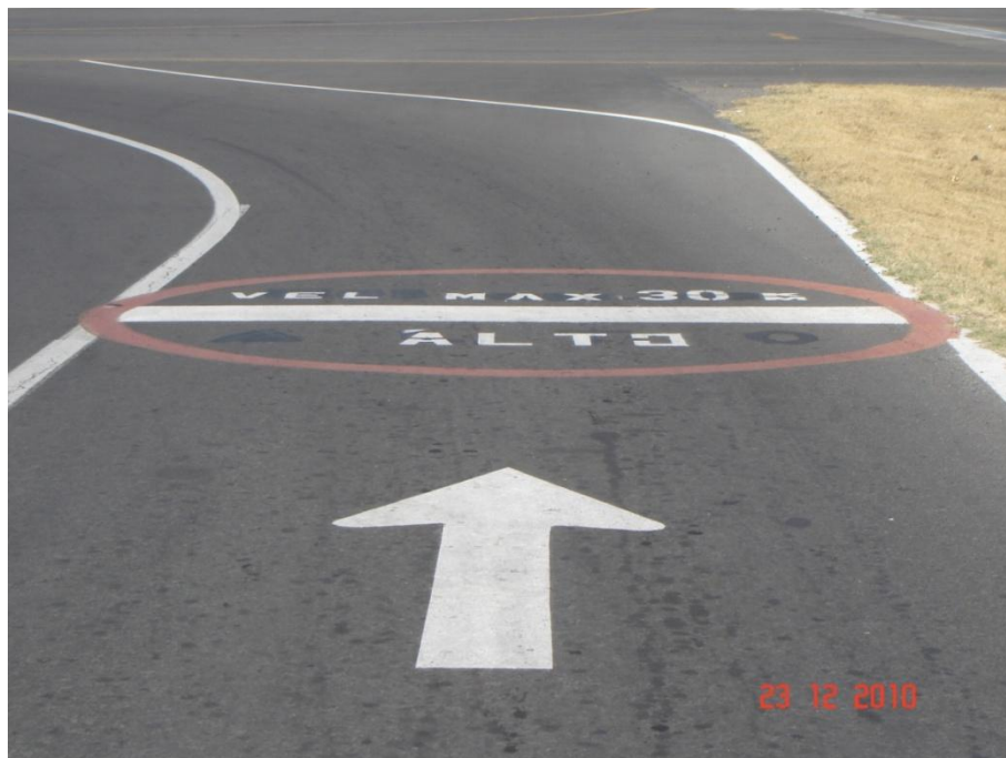
FIG.1.27. Marca de Parada antes de cruce de calle de rodaje para protección del margen de seguridad de aeronave.
