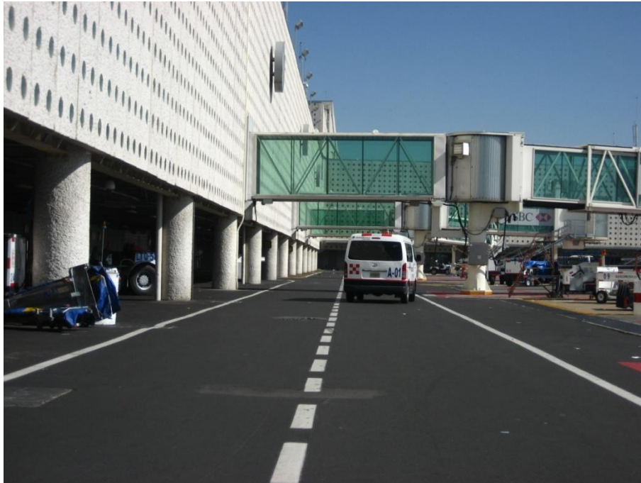
FIG.1.25. Vialidad vehicular en la Terminal 2.
