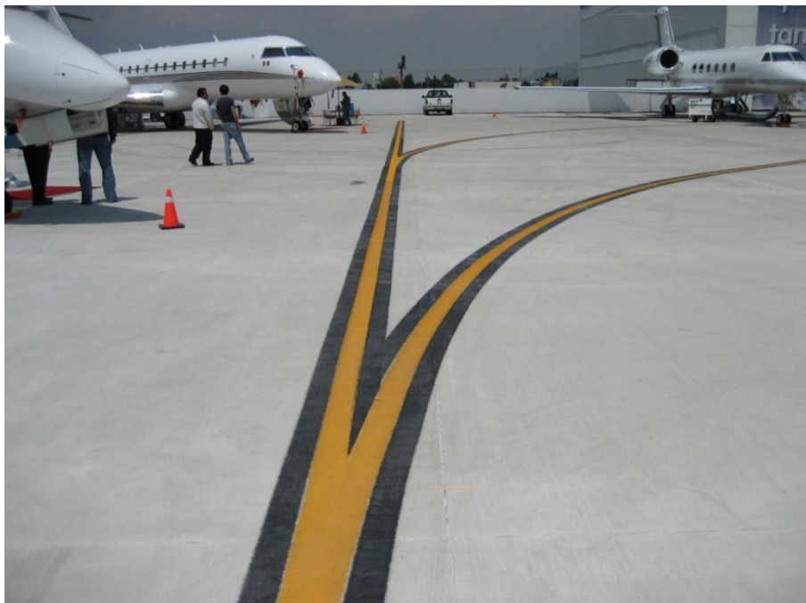
FIG.1.26. Resalte de un eje de calle de rodaje sobre una superficie de concreto. Recomendación de O.A.C.I. se marca el contorno en negro a manera de contraste.
