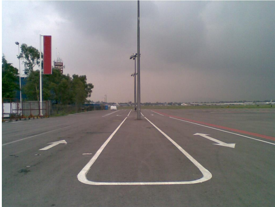
FIG.1.22. Vialidad de apoyo dentro de la plataforma remota oriente para estacionamiento de aeronaves.
