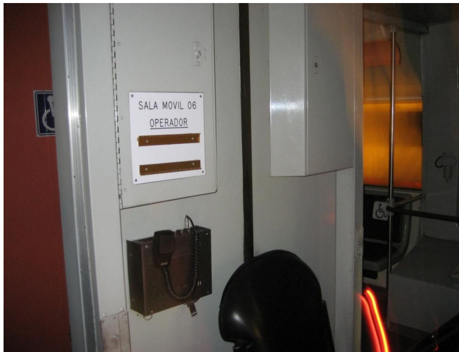
FIG.2.12. Justo atrás del habitáculo del operador, se encuentra el equipo de intercomunicación al habitáculo de pasajeros y las comunicaciones entre la Torre de Control (Control de Tránsito Terrestre) y Centro de Control Operativo.
