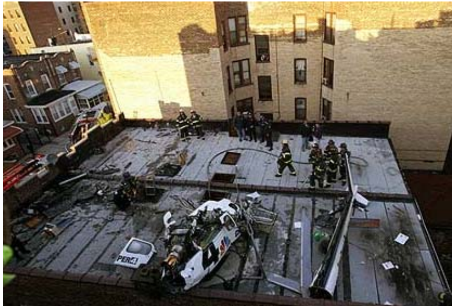
Figura 1. "Accidente en un helipuerto elevado".
