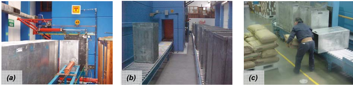
Figura 3.10 (a) Entrada de los contenedores a la cámara de irradiación para procesar los productos, (b) Salida de los contenedores de la cámara de irradiación, (c).Área descarga y retiro de dosímetros.
