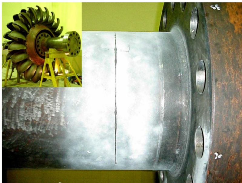
Fig. 1-7 Rotor agrietado en una turbina hidráulica Pelton
