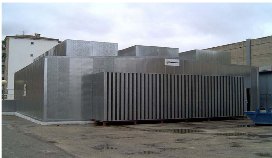
Figura 1.9. Ejemplo de un encapsulado acústico de Equipos de Climatización.
