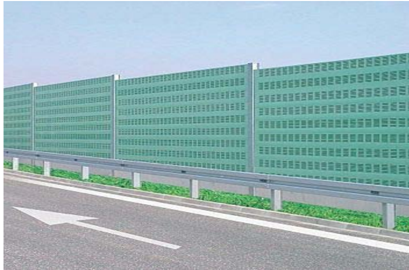
Figura 1.8. Ejemplo del uso de barreras acústicas.
