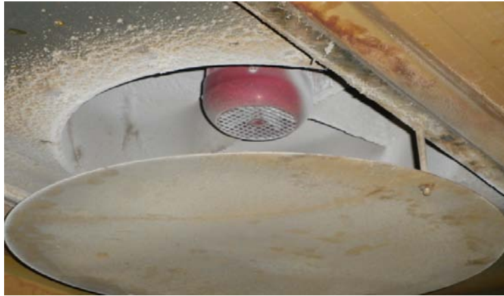
Figura 3.5. Fotografía de un ventilador de la máquina de espumado.
