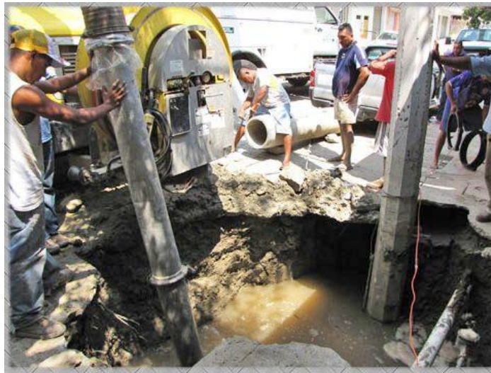
Figura 1.9. Reparación de una fuga.
