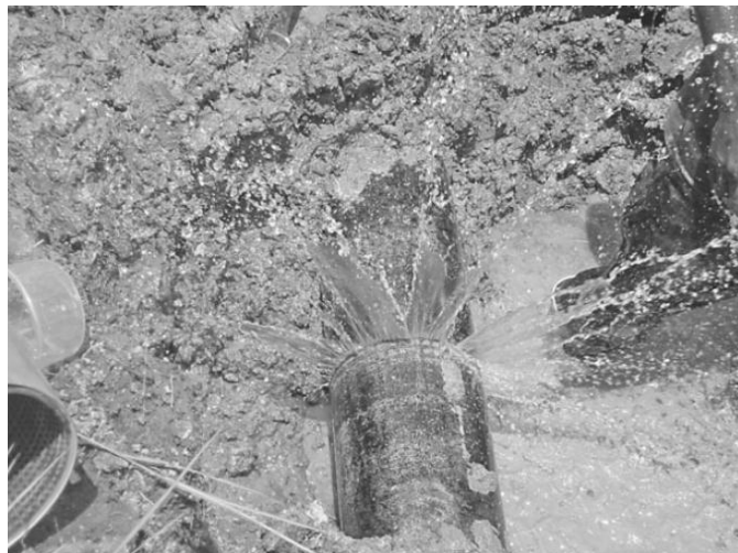
Figura 1.5. Ruptura en una tubería de distribución.
