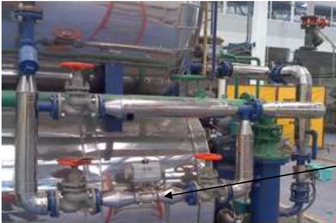
Fig. 3.29 Cabezal de Alimentación de Vapor a la Autoclave.
