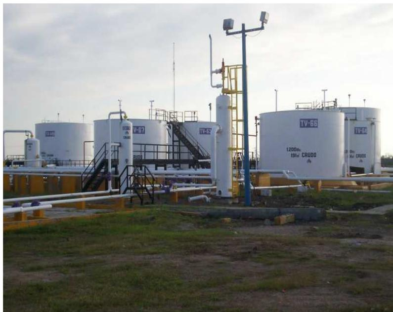
**Figura 4.2.** Tanques de balance donde se elimina el agua restante en el crudo hasta llegar a un máximo de 1% de humedad.
