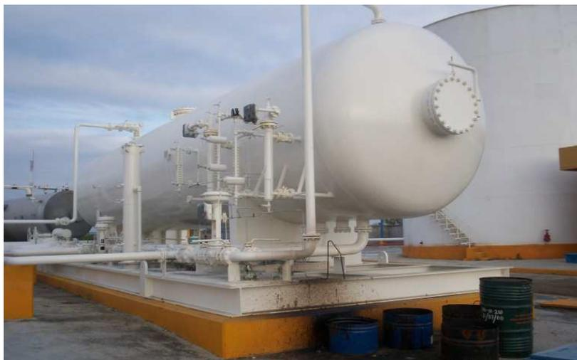
**Figura 4.1** Separador de agua libre localizado al principio del proceso de deshidratación del crudo en Campos Tamaulipas de PEP Altamira.
