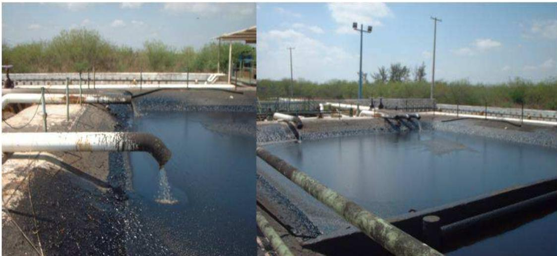
**Figura 4.3** Presa API. Recibe el agua que es drenada de los tanques deshidratadores, los tanques de balance y el Separador de agua libre.
