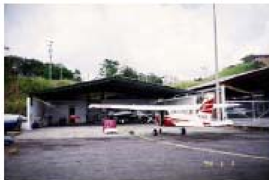
Taller de mantenimiento
