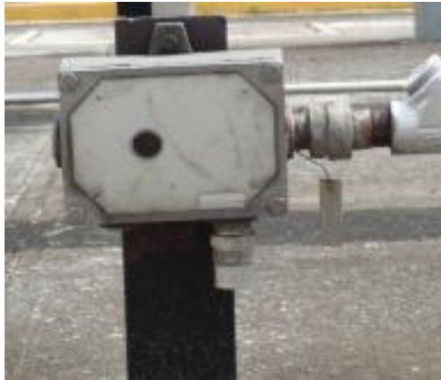
Figura 2.2 Detector de Mezclas Explosivas de tipo catalítico.
