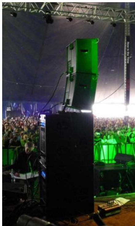
Figura 2.7 Sistema de monitores en SideFill.
