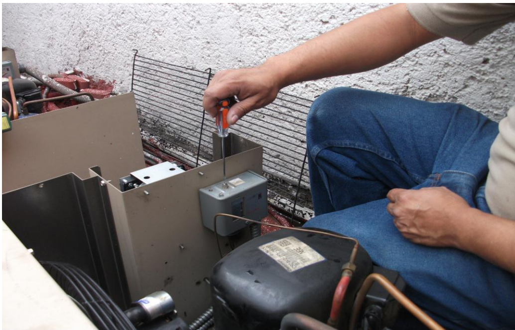
FIGURA 3.12 AJUSTE DE PRESOSTATO.
