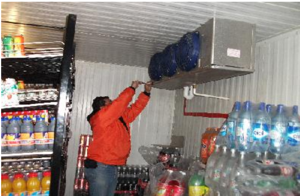
FIGURA 3.18 RETIRO DE TAPAS EN EVAPORADORES.
