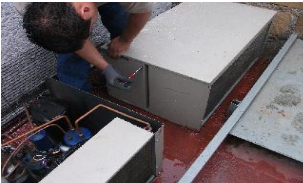
FIGURA 3.16 COLOCACION DE TAPAS PROTECTORAS.
