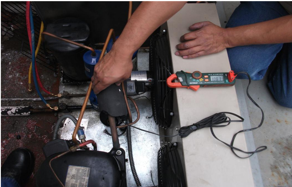
FIGURA 3.11 COLOCACIÓN DE SENSOR DE TEMPERATURA.
