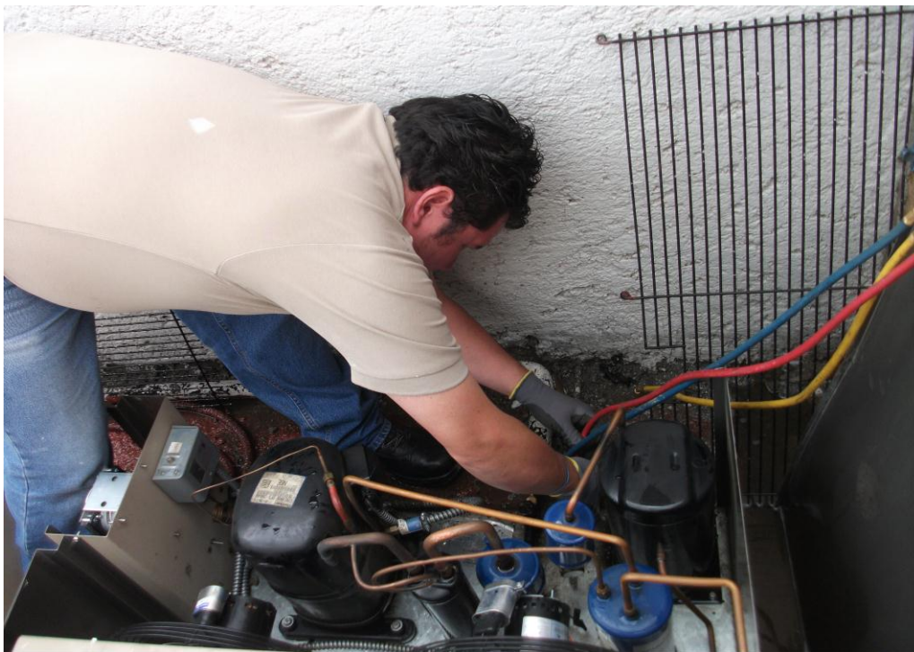
FIGURA 3.9 CONEXIÓN DE MANGUERAS.
