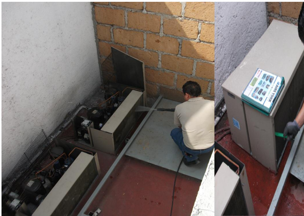
FIGURA 3.8 LAVADO DE CONDENSADORA.
