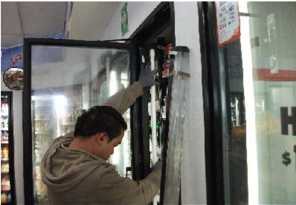
FIGURA 3.23 VERIFICACIÓN DE LAS LUMINARIAS.
