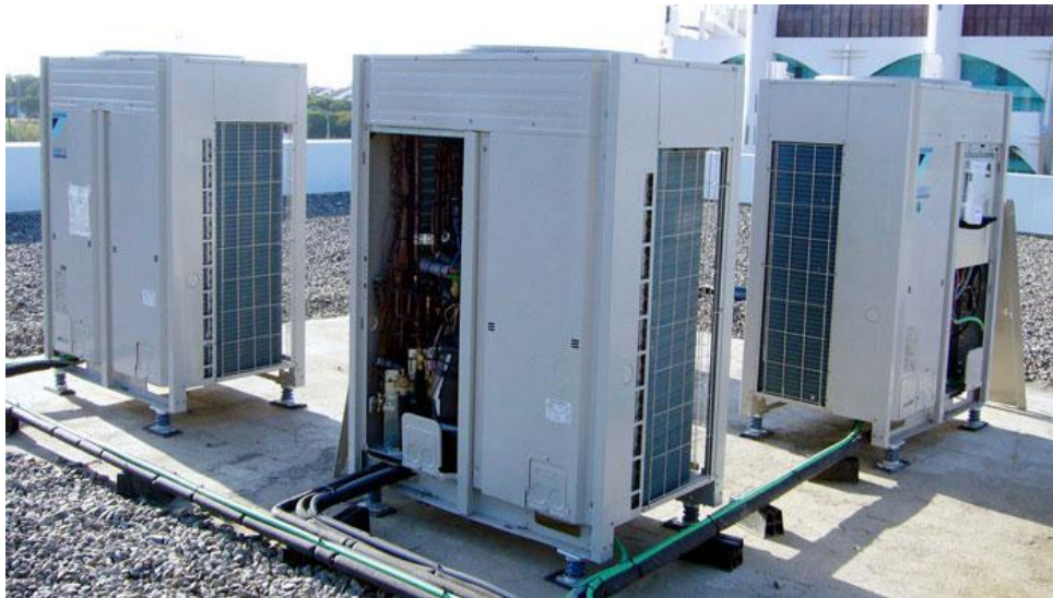
FIGURA 2.8 SISTEMA DE AIRE ACONDICIONADO REFRIGERACIÓN Y CALEFACCION
