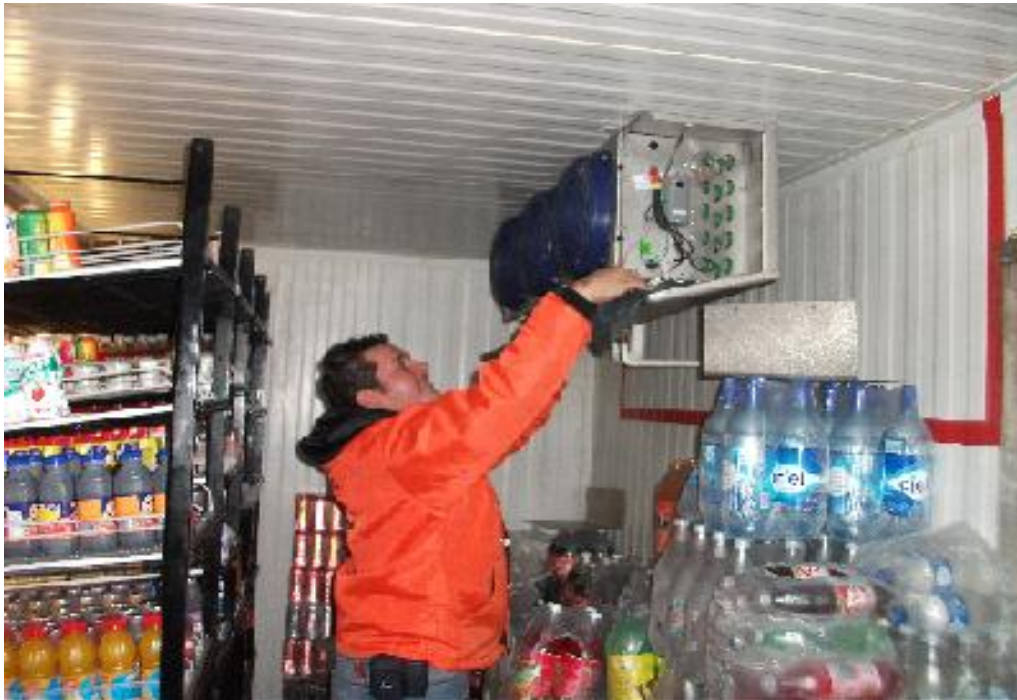
FIGURA 3.19 LIMPIEZA INTERNA DE LA EVAPORADORA.
