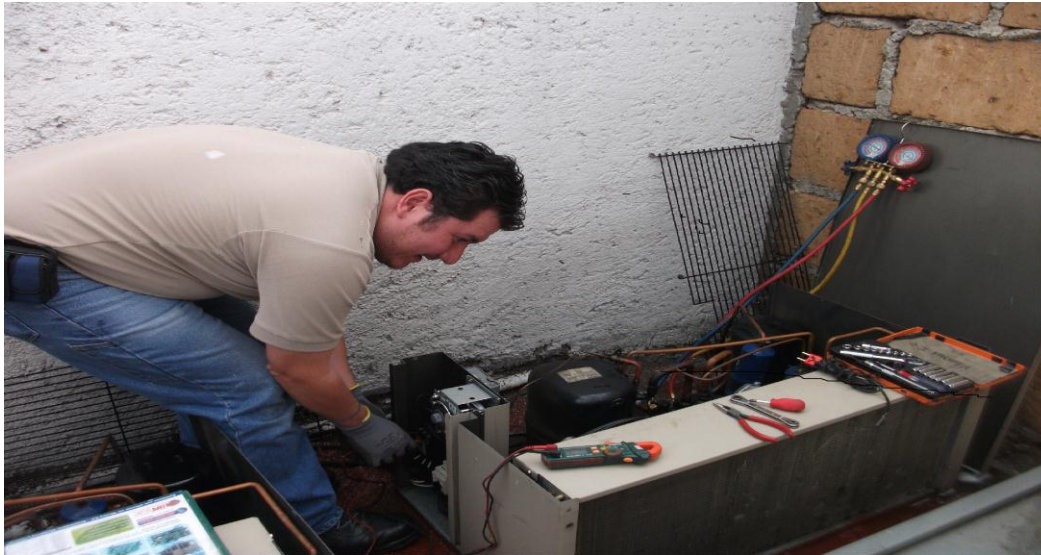
FIGURA 3.5 ARRANQUE DE LOS EQUIPOS.
