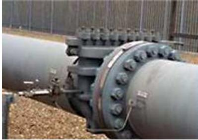
**Figura 3.13** Instrumento de medición sumergible “Placa de Orificio” instalado en líneas de inyección [16]
