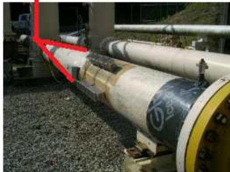
Figura 4.8 Acoplamiento del flujómetro ultrasónico en tubería
