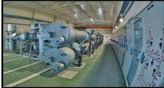
c) Figura 11 Ejemplo de Subestación SF 6
