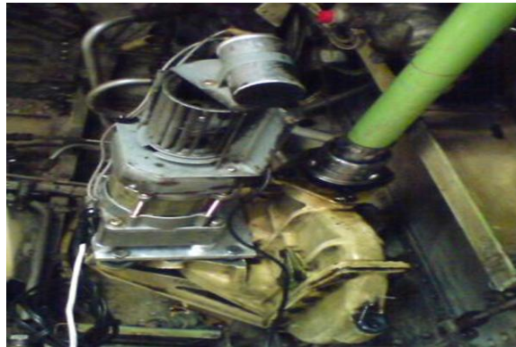
Figura 80. Motor eléctrico montado en el pozo del tren de aterrizaje.
