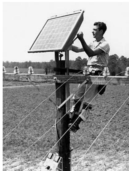
Figura 1.12 La original batería solar de laboratorios Bell [Encarta, 2008].
