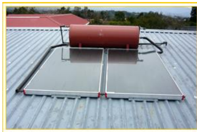
Figura 1.2 Calentador solar, tipo termosifón. Fuente: termi-solar.com.
