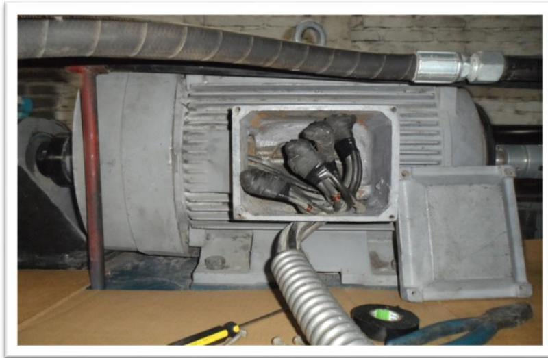
*Figura 3. 6 Conexión a motor*
