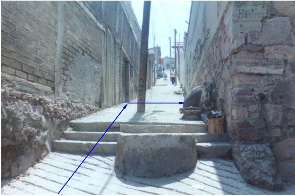
Fotografía 33 Llegada al Tanque - Rebombéo GM-11 por la Parte Posterior para Propuesta
