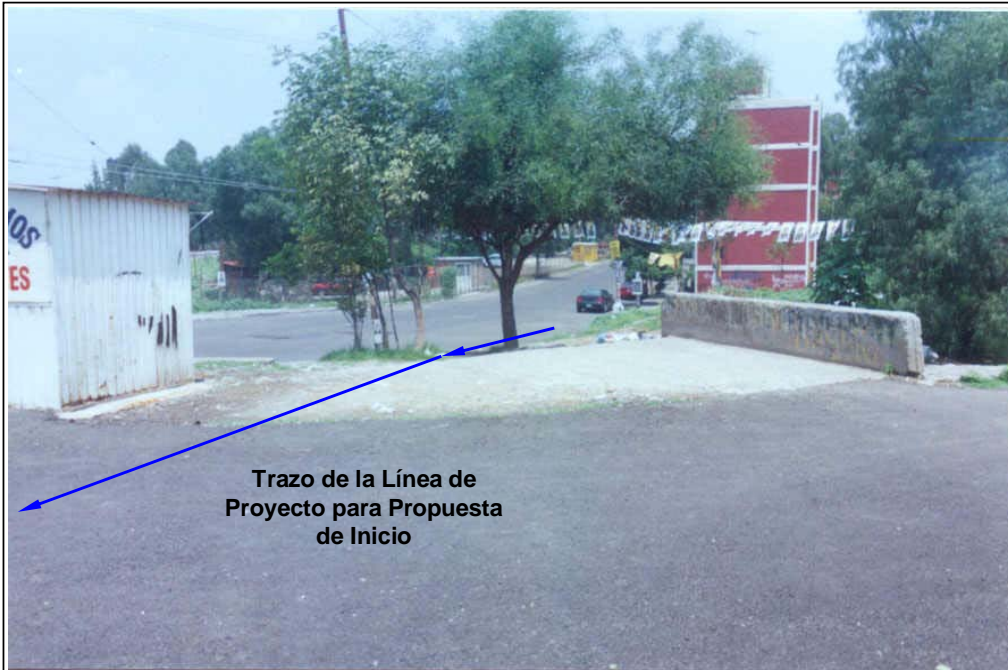
Fotografía 7 Trazo de la Línea de Proyecto en el Cruce con Río San Javier, Visto desde la Margen Izquierda
