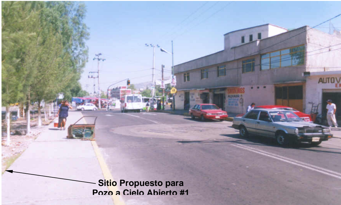
La banqueta sur de Boulevard del Temoluco, entre Av. Cuauhtemoc y Av. Puerto de Mazatlán.
