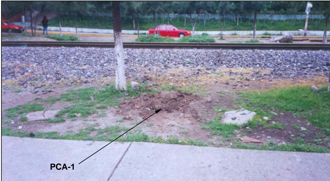
Aspecto general del PCA-1 localizado en Boulevard del Temoluco, entre Av. Cuauhtepac y Av. Puerto de Mazatlán
