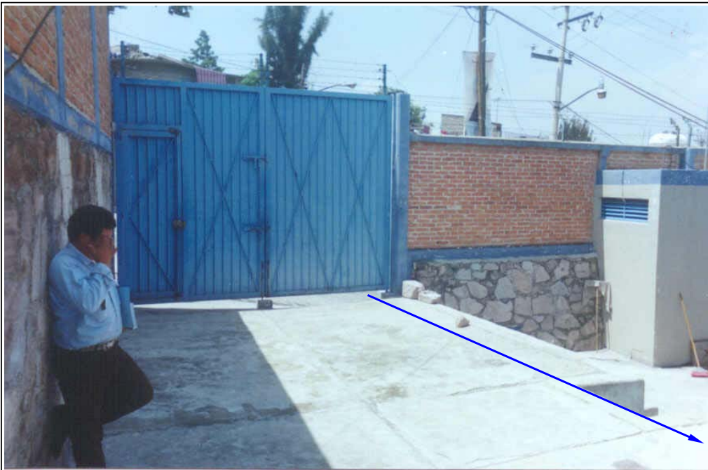
Fotografía 28 Trazo de la Línea de Proyecto Dentro del Tanque - Rebombeo GM-11 para las Alternativas #1, #2 y #3
