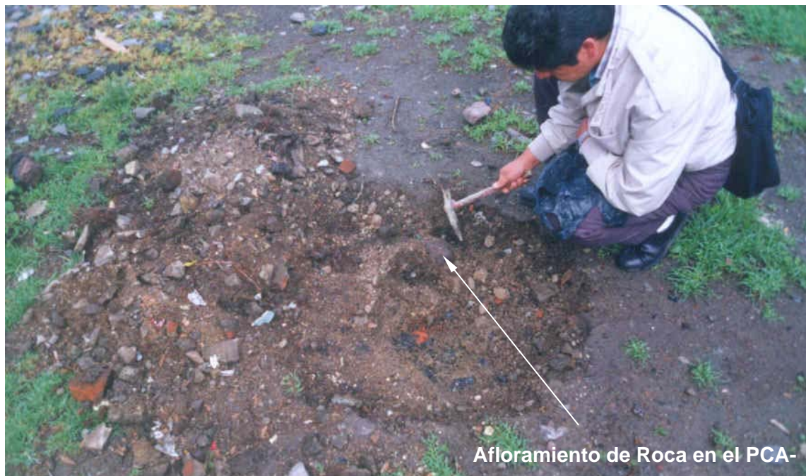
Aspecto de la inspección geotécnica del PCA-1
