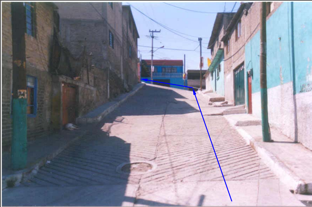
Fotografía 23 Trazo de la Línea de Proyecto en Huitzilopochtli y Fresno para Alternativas #1, #2 y #3
