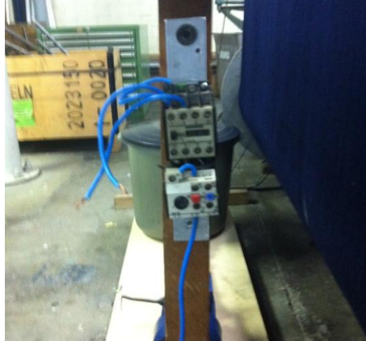
Figura 5.5 Colocación del contacto y protección termo-magnético
