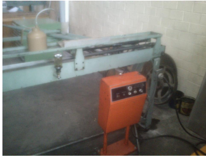
Figura 3 1 Caja de control electromagnético
