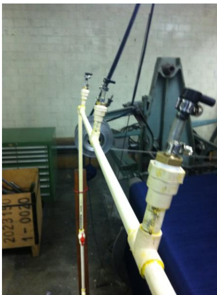
Figura 5.3 Pegado de Tubería CPVC
