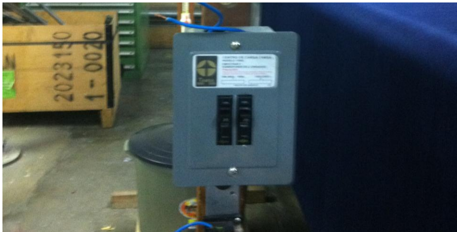
Figura 5.4 Colocación de las protecciones.
